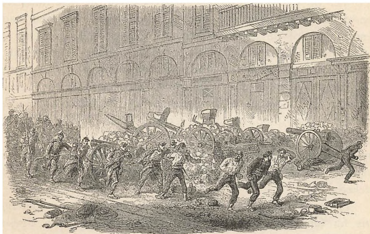
Gadekamp ved en Barricade.
