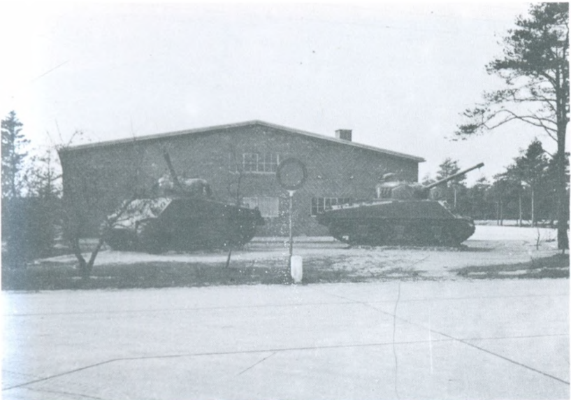
Den første pansergarage.
