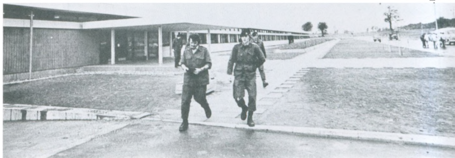
Centerbygningen set fra indkørslen til køkkengården. Foto: J. de Fries.
