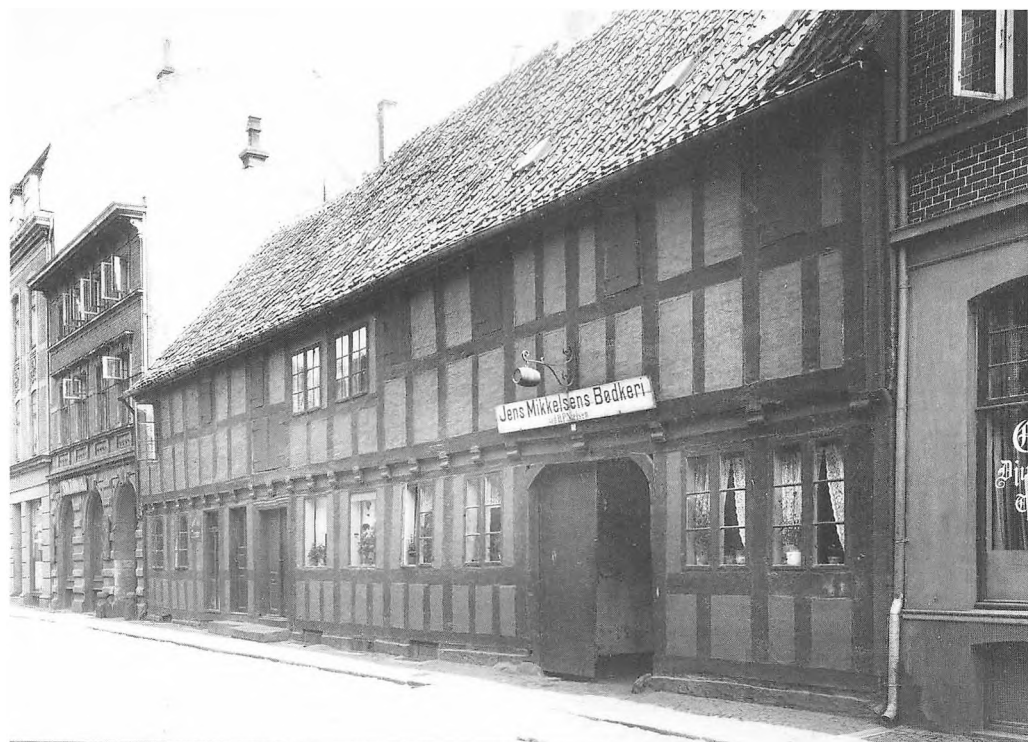
Mejlgade 72, hvor Grover Nielsen boede med familien i den sidste før han forlod skolen og emigrerede til Canada. Som det ses, bibeholdt H.P. Nielsen virksomhedens gamle betegnelse med sit eget navn diskret tilføjet nedenunder. Bemærk bødkerskiltet med tøndlen over porten. Foto fra 1917 i Lokalhistorisk Samling
