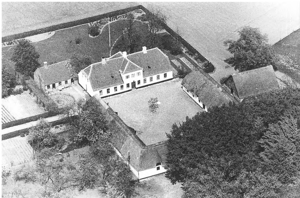
Jarlsminde ved Århus 1947. Kun hovedhuset eksisterer endnu, idet avlsbygningerne blev revet ned i 1969. Gården blev opført af ler, hentet tæt syd for gården. Pisébyggede huse består af en lerkappe med en halvtstensmur udenpå. Murene er 80 cm tykke. Indvendig har huset, der er på ca. 350 kvadratmeter, stort set bevaret sin oprindelige ruminddeling. Byggestilen tyder på, at arkitekten var hollandsk. Gården ejes i dag af Einar Rud Pedersen, hvis farfar købte den i 1944. Foto hos forfatteren
