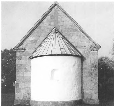
Den smalle apsis på Tulstrup kirke. Det overkalkede parti er opført delvis af frådsten. Foto: Bo Gregersen, 2000.
