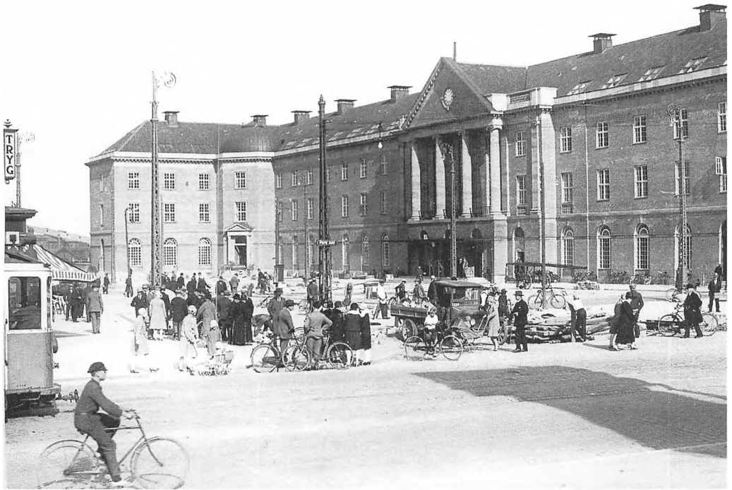
Statsbanerne foreslog i 1925 opførelsen af en bygning, der skulle være fælles for både postvæsen og statsbaner. Planen blev gennemført ved banegårdsbyggeriet 1927-29.. Hovedpostkontoret er i tre etager, men har på grund af niveauforskellen yderligere to kælderetager under Banegårdsplads. Billedet her er fra juli 1929.
