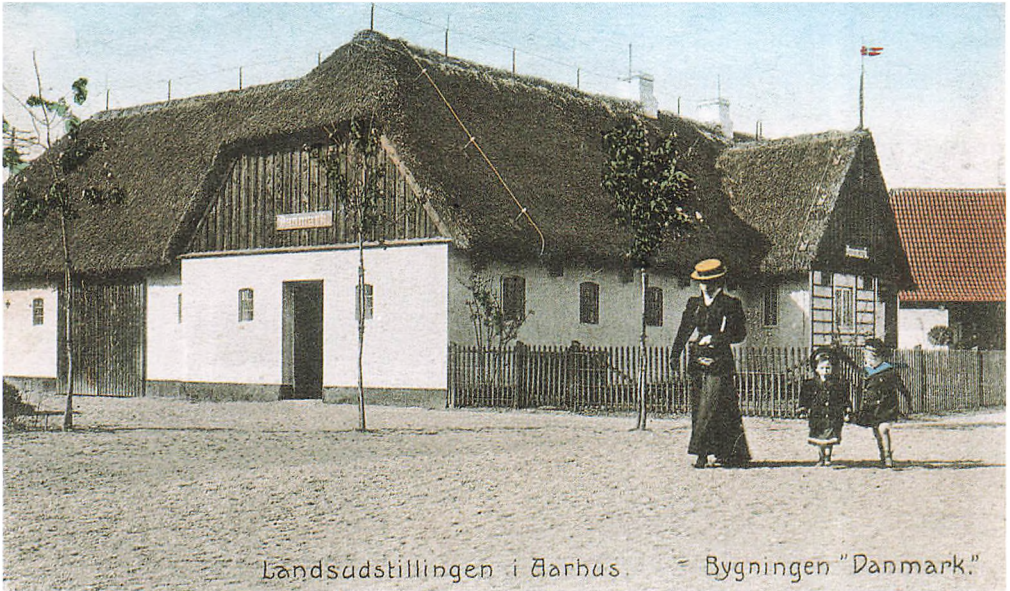
Danmarkshuset som det tog sig ud på Landsudstillingen i udkanten af Stationsbyen. Læg mærke til det omfattende lynafledningsanlæg, som huset er blevet udstyret med. Kort i Erhvervsarkivet, efter foto af Edu. Monsrud.
