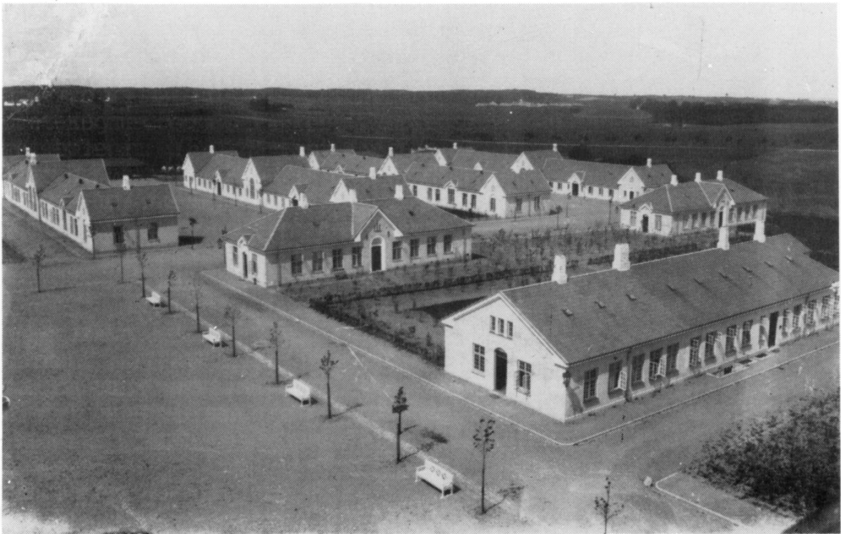
De nyopførte kasernebygninger ,set fra administrationsbygningens tårn mod NØ. Bag Kongevejen med de små vejtræer skimtes den tilsvarende kaserne ved Sandholmgård. Alle fotografiets bygninger eksisterer næsten uændrede i dag.
