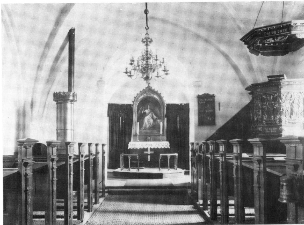
Det gamle alterparti i Lillerød kirke var omgivet af to mørke portierer, der dækkede for præsteindgangen i østgavlen (tårnet). Bemærk kakkelovn og aftræksrør gennem hvælvingerne.
