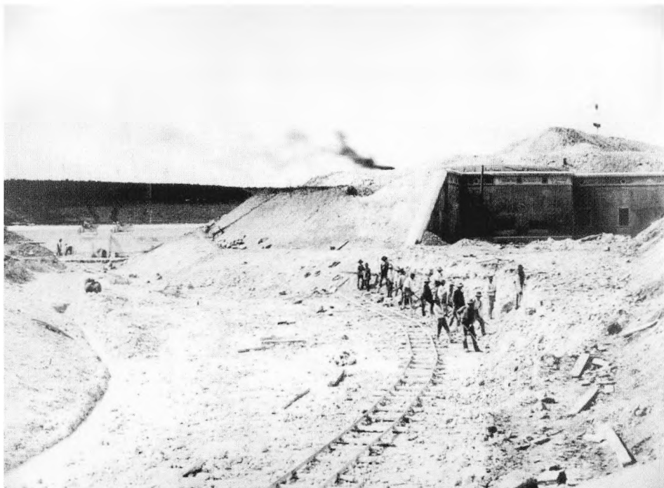
Udgravningen af Vestvoldens Husumafsnit og opførelse af dobbeltkaponieren til kanonerne, der kunne bestrype voldgraven på langs, 1889-90. (foto: Tøjhusmuseet)
