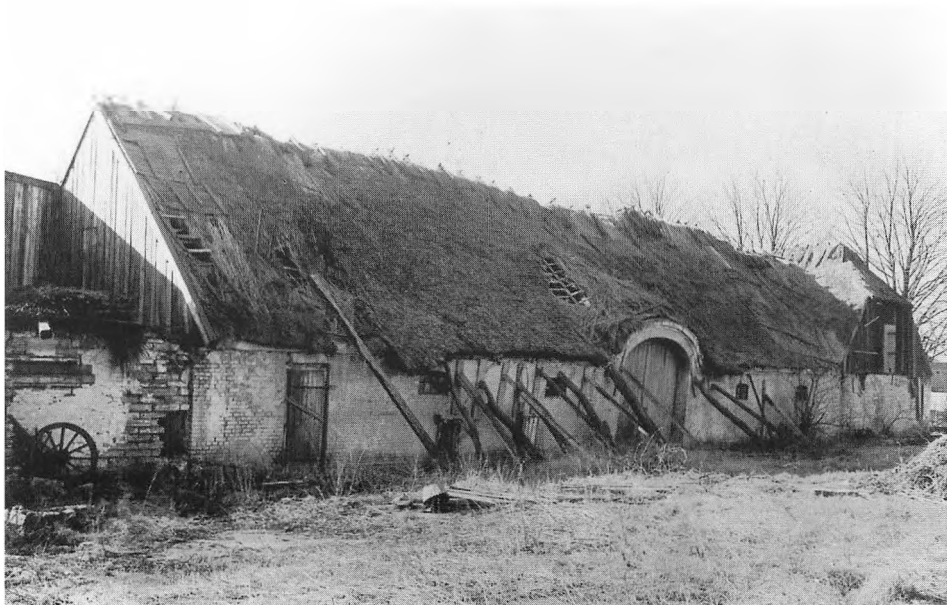
Søgård var den sidste af Husums gårde, der blev revet ned. Men efter at jorden var solgt fra, gik den hurtigt i forfald. Billedet viser udlængerne i forfaldsperioden. (foto: ca. 1940. Bymuseet)
