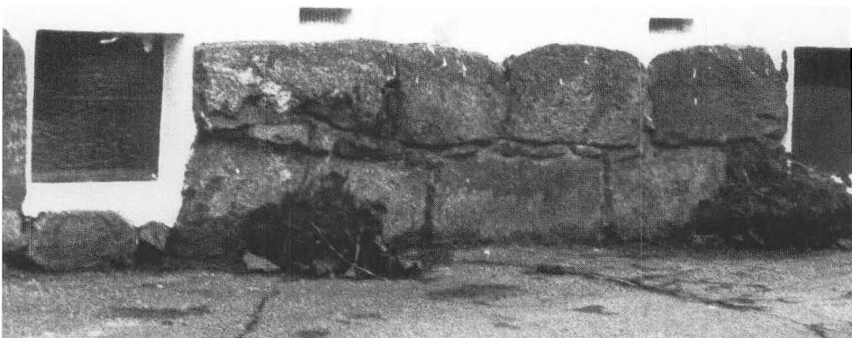
Porcelænsfabrikant Dahl-Jensens nu nedrevne villa var bygget på en sokkel af granitkvadre, der blev fundet i jorden, da kælderen blev gravet ud. (foto: Kn. Bertelsen aug. 1980)
