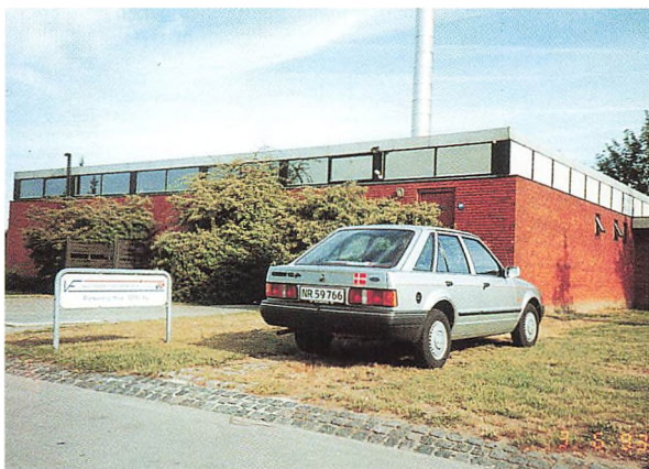
Vallensbæk Nordmarks Fjernvarmeværk A.m.b.a. juni 1993.
