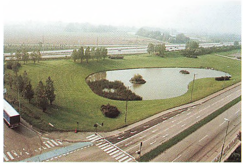
Også regnvandsbassinet ved Vallensbækvej udgør en sø, men er lavvandet og bliver flittigt brugt til modelskibssejls. Foto: Finn Pilborg september 1989.
