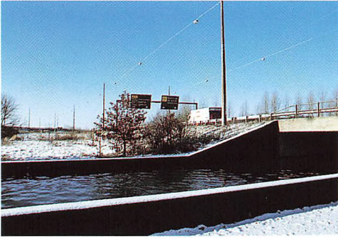
Afvandingskanalen, der er ført under Holbæk-motorvejen, forbinder Vallensbæk Sø med Tueholm Sø. Foto: Peter Sorenius januar 1995.
