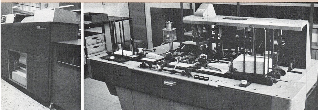
Databehandlingen resulterer i udskrivning af både journaler og kontoudskrifter på f. eks. »IBM-PRINTER« med 200 linier i minuttet, og afsendelsen af kontoudskrifter sker på »BELL & HOWELL«-kuverteringsmaskine. Den her viste klarer 10.000 udskrifter i timen. Maskinparken klarer pakning og udsendelse af over 100.000 udskrifter hver ultimo måneden og 31.12. over 1/2 mio. udskrifter.
