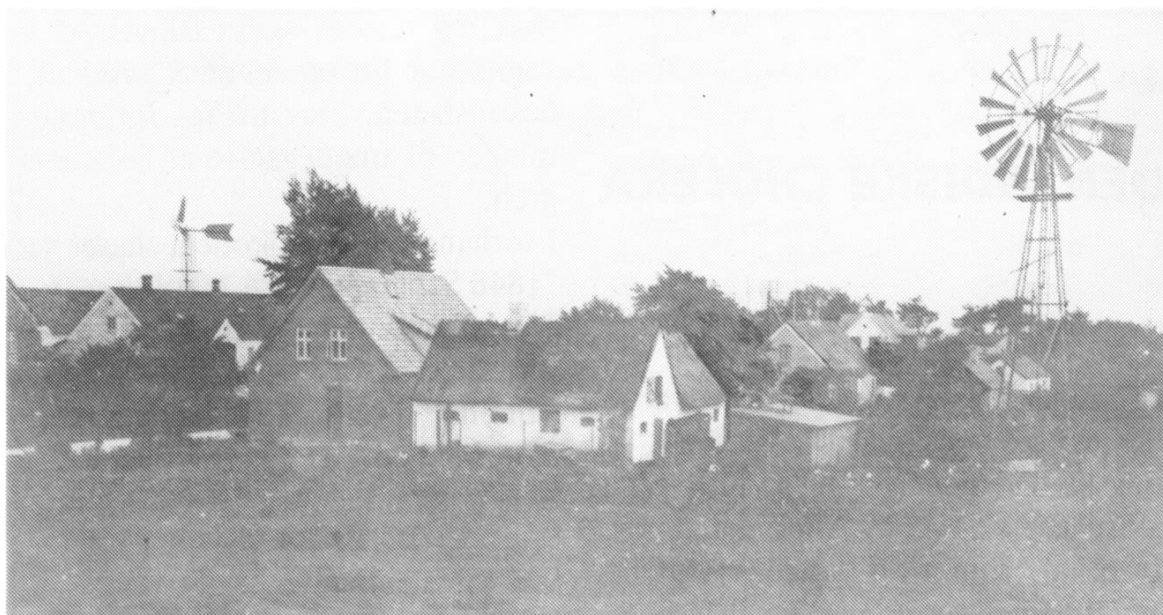
Lynges bygade 9 med vindmøllen, der indtil 1937 pumpede vandet op. Til venstre: Lindhøjgårds elektricitetsmølle.
