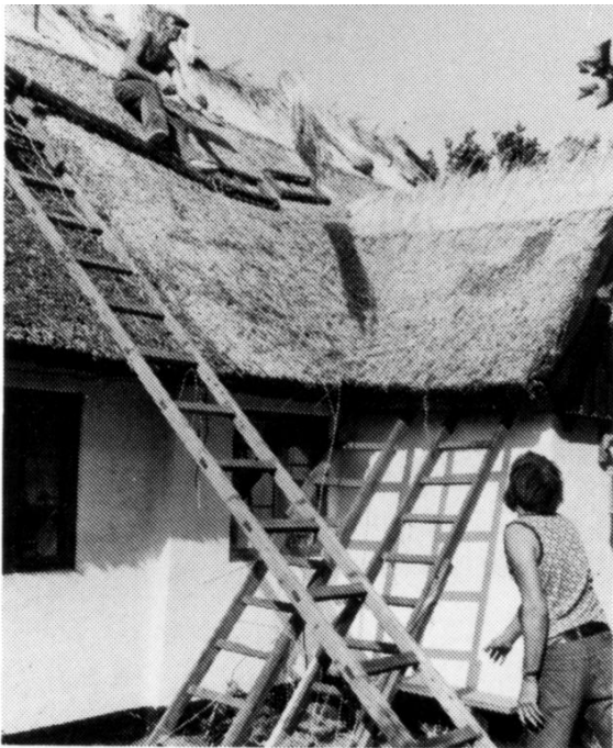
Det er hurtigst, - men lidt drøjt for medhjælperen - at kaste rørbundterne op til tækkeren på taget. Foto: Ole Høegh Post. 1982.
