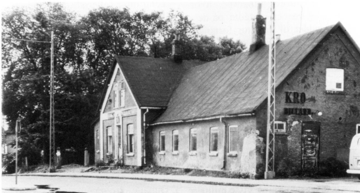
I slutningen af 1950'erne blev der ikke ofret meget på vedligeholdelsen af de primitive krobygninger med tagpaptage og rødkalkede mure. Gunnar Larsen Foto.
