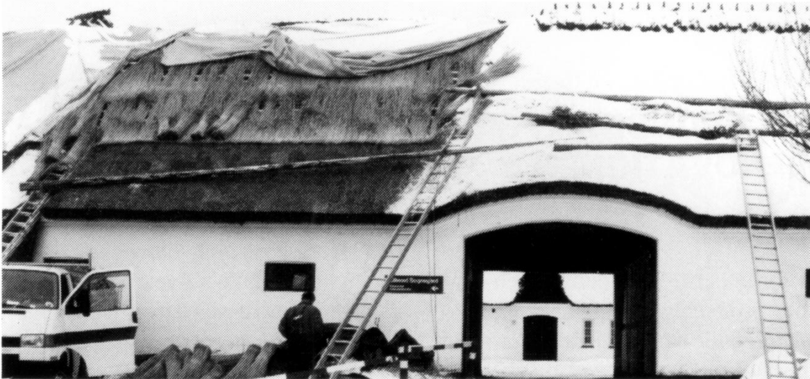
Kirkehavegård omtækkes i januar 1994 - i frost og sne. Der skal meget dårligere vejr til at stoppe Jørgen Kristiansen fra Meløse. Foto: Ole Høegh Post.
