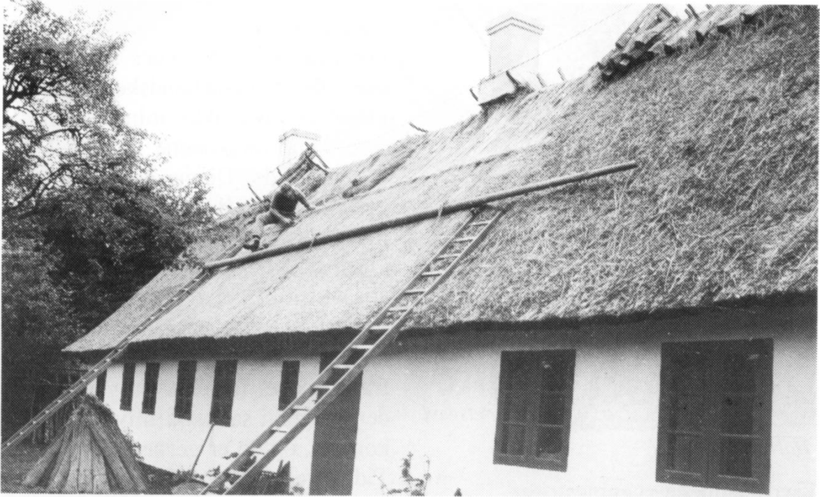
Tækkemandens enkle "stillads" - en rund tækkebom i reb fra tagryggen. Wolthersvej 6, 1985. Foto: Ole Høegh Post.
