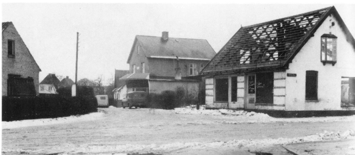
Dette er Allerød Stationsvej set mod vest, hvor det nye posthus nu ligger. I 1958 nedrev man Paradisgården's genbo og banehuset på "Øen" (til venstre). I midten "Villa Vito" med butikspavillonen. Foto: Gunner Larsen.
