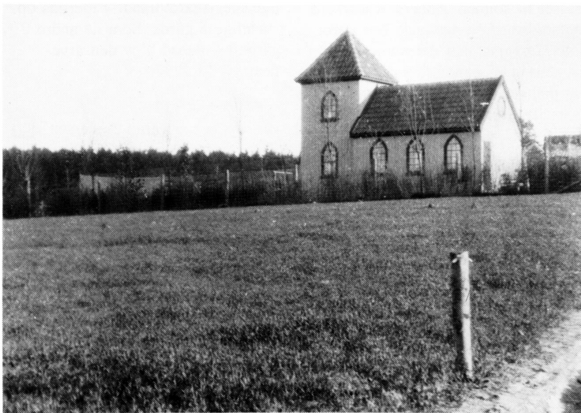
Øxenholms hønsehus. Ifølge grosserereren var det bygget som et udsigtstårn med en tilbygning, men man må give pastor Andersen ret i, at det ligner mere en kirke end et udsigtstårn. Øxenholm er for øvrigt et forbygget husmandssted, som vi næsten ikke ved noget om. Foto: August Andersen. 1928.
