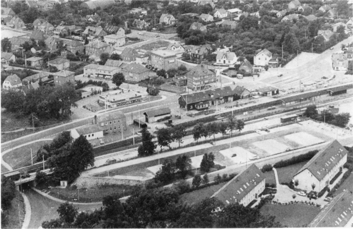
I 1967 var der ændret meget på Stationspladsen. Øens banehus og den ene del af "Paradisgården" mangler. Kroen er blevet til et Irma-marked og Mølcks Konditori er netop fjernet (træerne til venstre, hvor nu benzintanken ligger). Foto: Allerød Posten, 1967.
