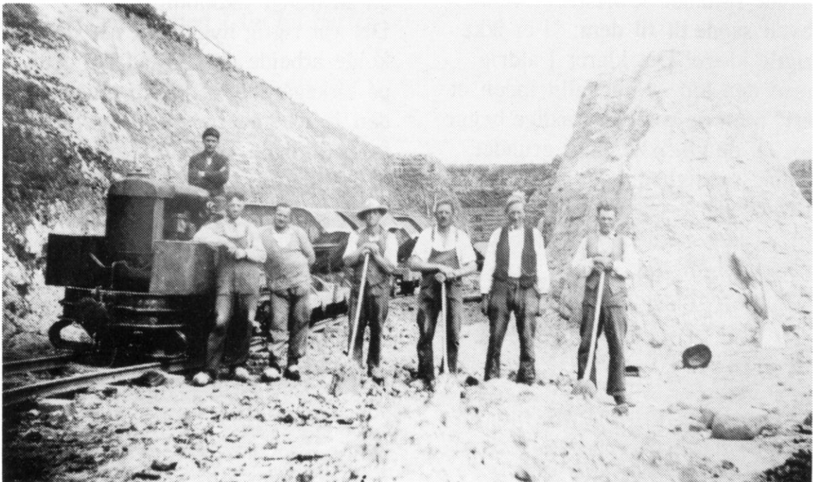
Arbejdere ved tipvognstog i Nymøllegraven.
