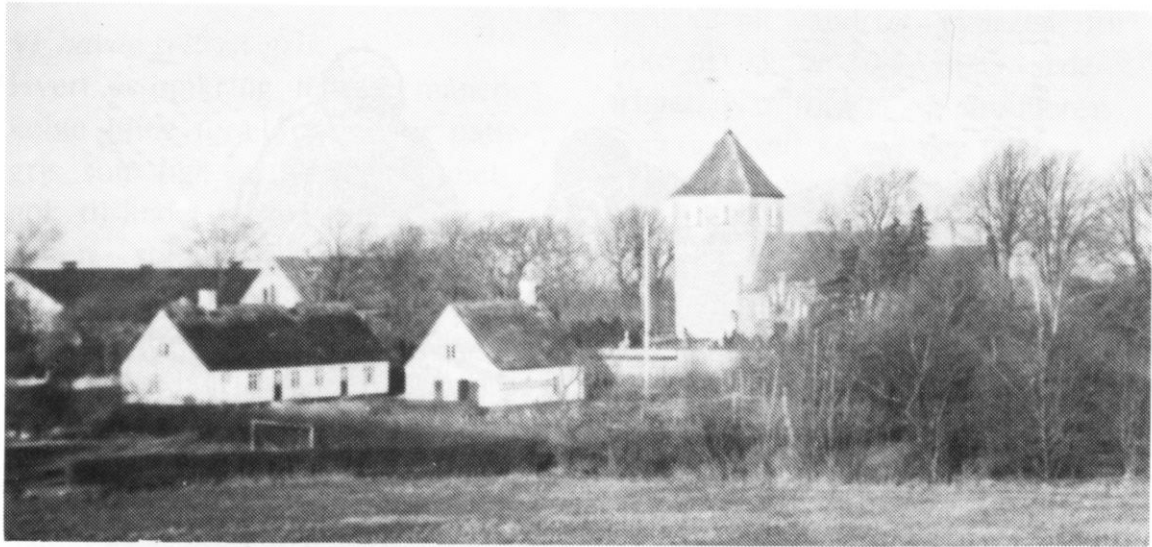
Lyngby med kirken og graverens hus, "Den gamle skole" med udhuset set fra sydøst i 1940'erne.
