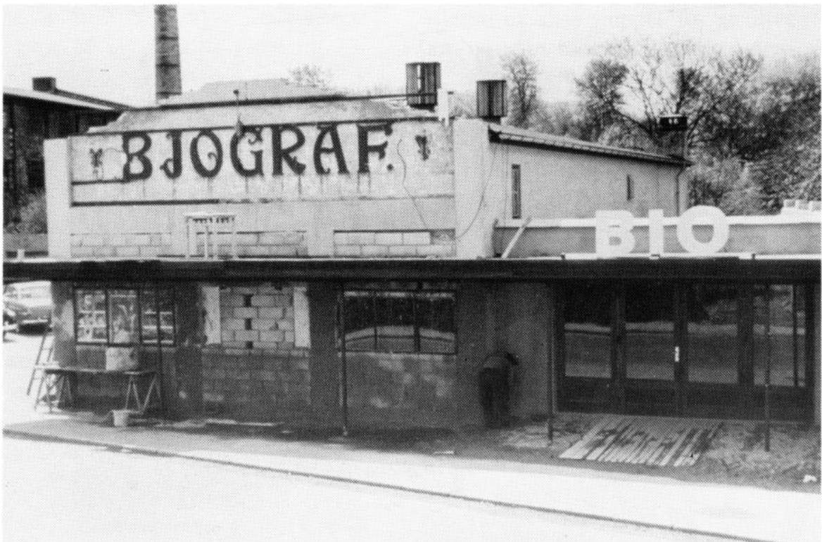
I 1958 blev biografens facade bygget om. Den oprindelige facade-overskrift dukkede frem, og den firkantede gavlfacade blev ændret til en gavlspids.
