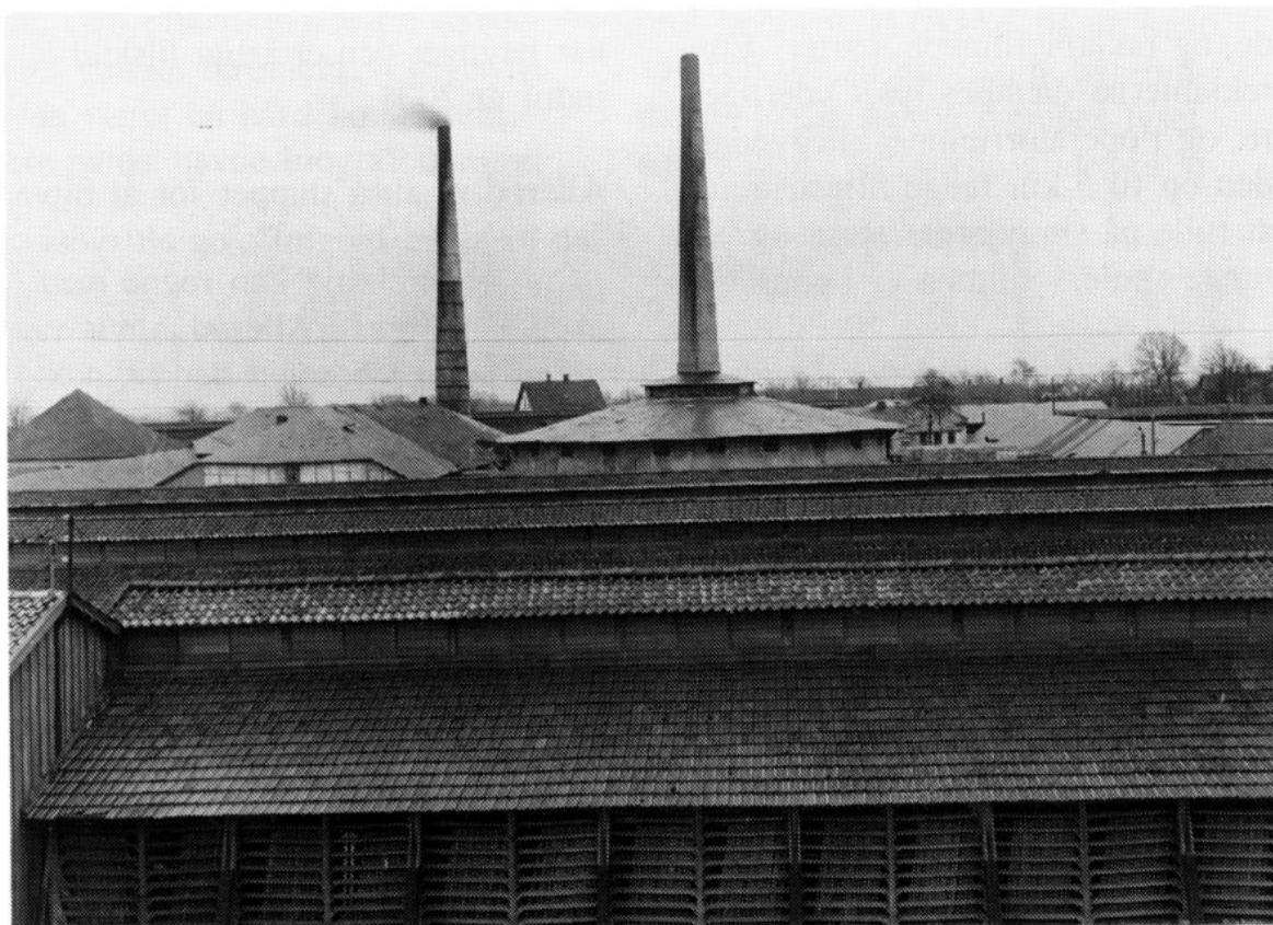
Blovstrød Teglværk set fra nord. Billedet, der skyldes Chr. Mouritzen, Birkerød, må være fra de første år i dette århundrede. På billedet ses pottemageriskorstenen til højre og ringovnsens og langovnsens skorstene til venstre. I midten anes en (firkantet), for os ukendt skorsten.
