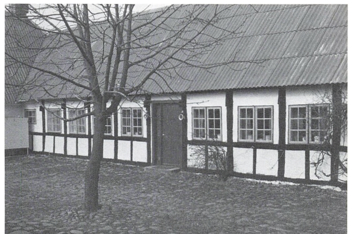
M. B. Jensensvej 12, stuehusets gårdfacade. (NM 1976).
