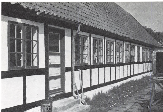
Hæderlighedsgyden 11, stuehusets østfacade. (NM 1975).
