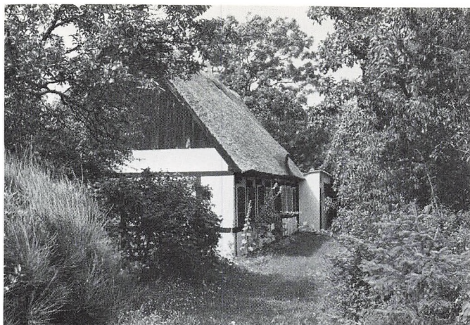
Hæderlighedsgyden 3, østfacaden. (NM 1977).
