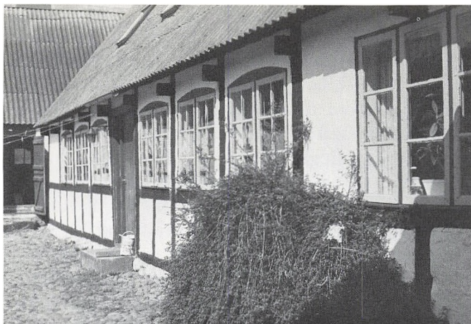
M.B. Jensensvej 9, stuehusets gårdfacade. (NM 1975).
