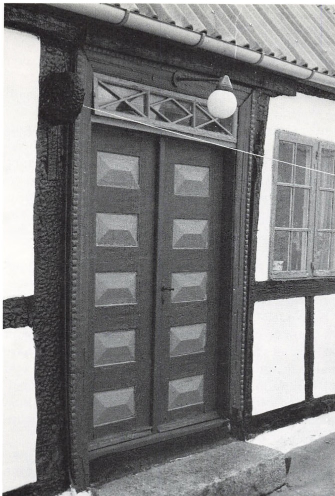
Hæderlighedsgyden 9, indgangsdør fra gårdsiden. (NM 1977).
