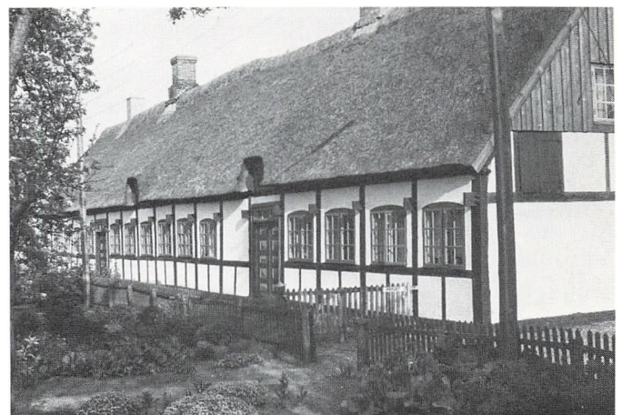
Morten Madsensvej 20-22, nordfacaden. (NM 1975).
