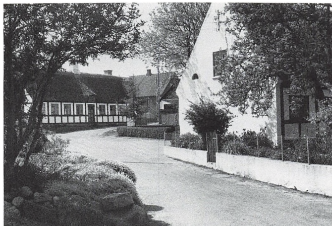
Hjortgyde 2, stuelængens facade til Skræddertorvet. (NM 1975).
