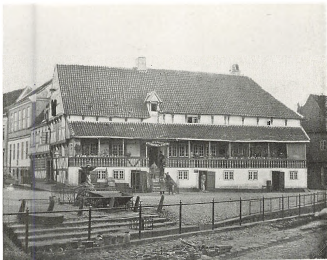
En af Aalborgs gamle, nu nedrevne Bindingsværksbygninger. (Efter Fotografi. — Hvor denne gamle Bygning før lå ved Østeraa, ligger nu Sparekassens Bygning udfør Christian IX. Rytterstatue.)
