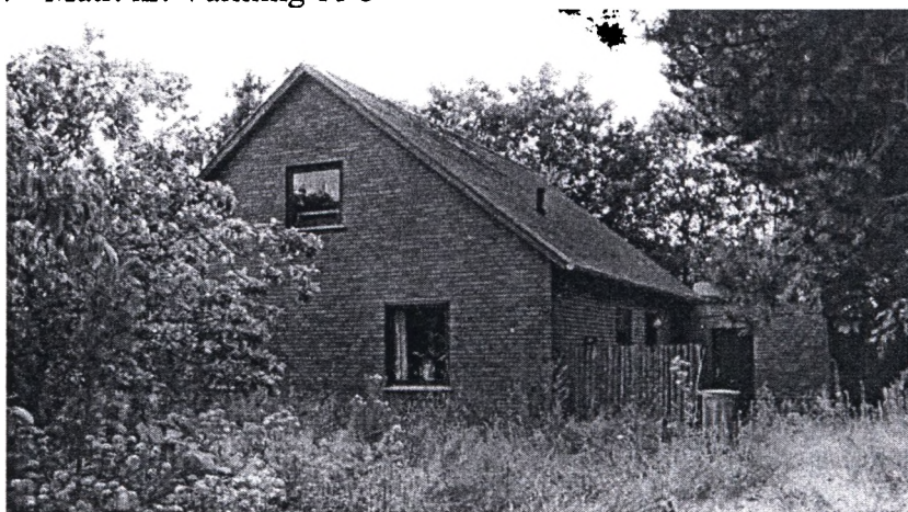
Opført 1964 som aftægts hus for gården Varmingvej 20, lejebolig Osvald Simonsen Hans Brunsgaard 1998 (Udlejes)
