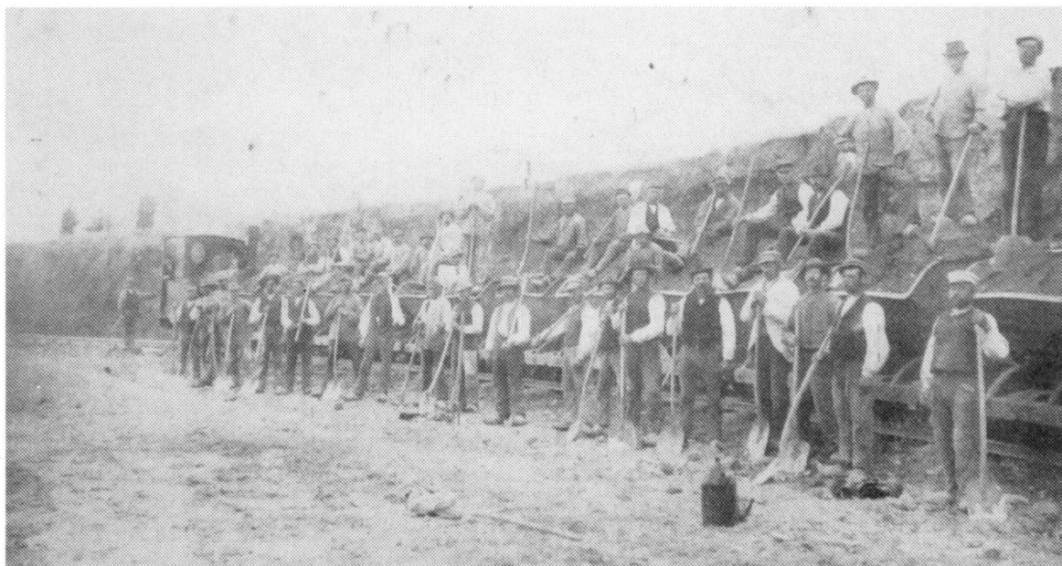
De første mange år gravede man ler til teglværkerne med håndkraft. Her er Allerød Teglværks lertog ved at blive fyldt i en lergrav. 1920'erne?
