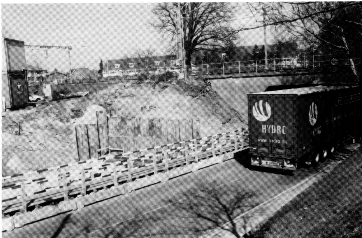
Udgravningen til den tiltrængte viaduktudvidelse, maj 2005.
