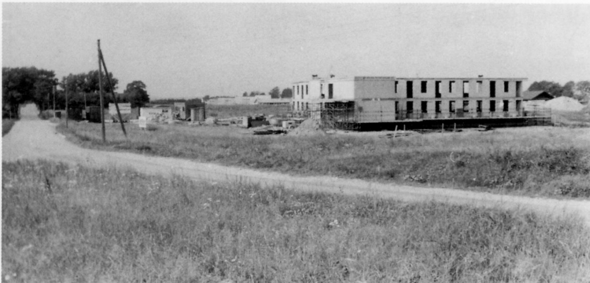
Den gamle Kollerødvej og rådhusbyggepladsen, september 1973.
