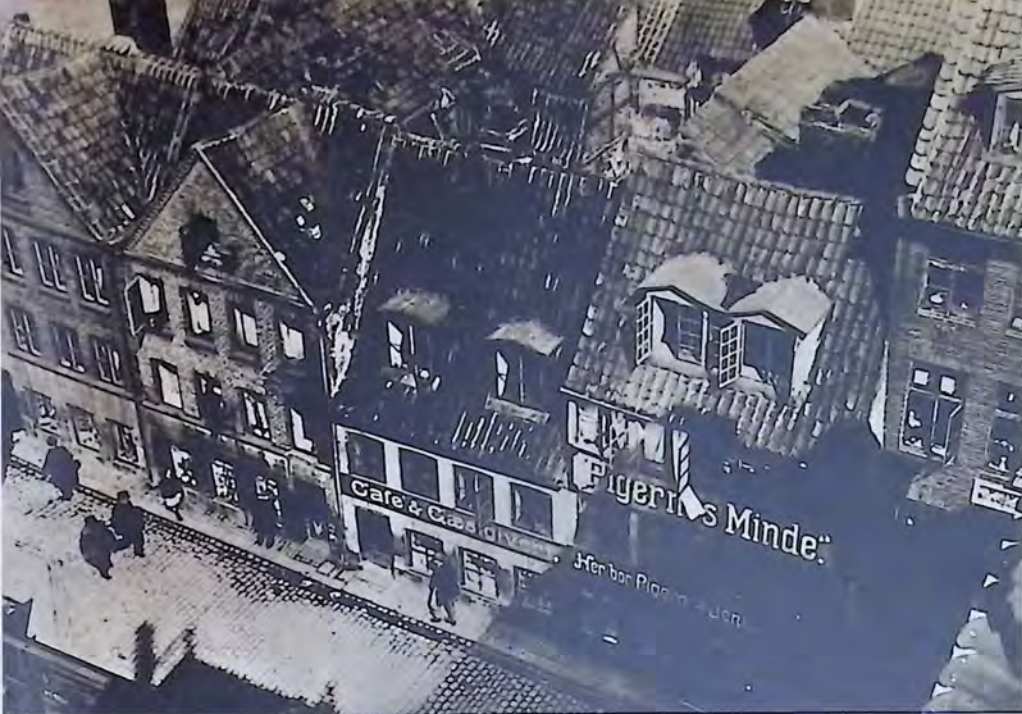
← Holmensgade med de gamle Huse, som i deres Kærne var Christian IV.s Skipperboder, opført som Rækkehuse af Bindingsværk. Om Husenes sidste Beboere taler Skiltene deres tydelige Sprog.
