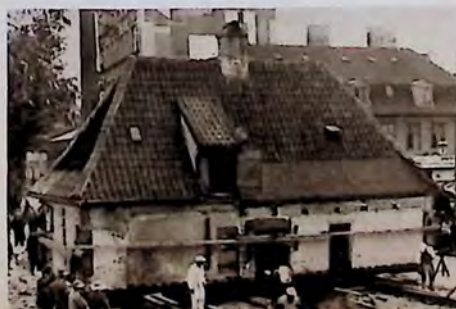
↓ Da Gaden i 1936 skulde udvides, blev Acciseboden sat paa Ruller og flyttet et Stykke tilbage.
