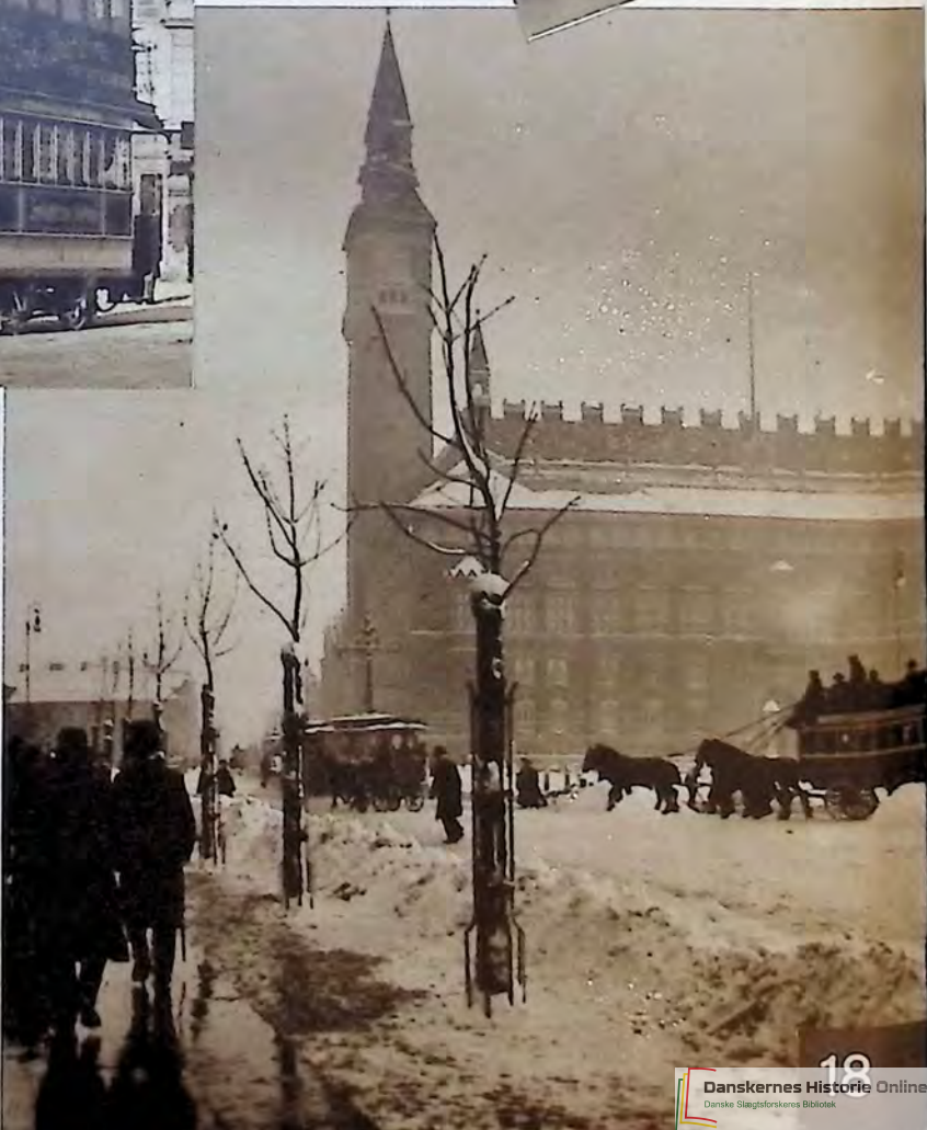
→ Raadhuspladsen i Sne. Omnibussen ad Strøget kører i den Anledning med Firspand.
