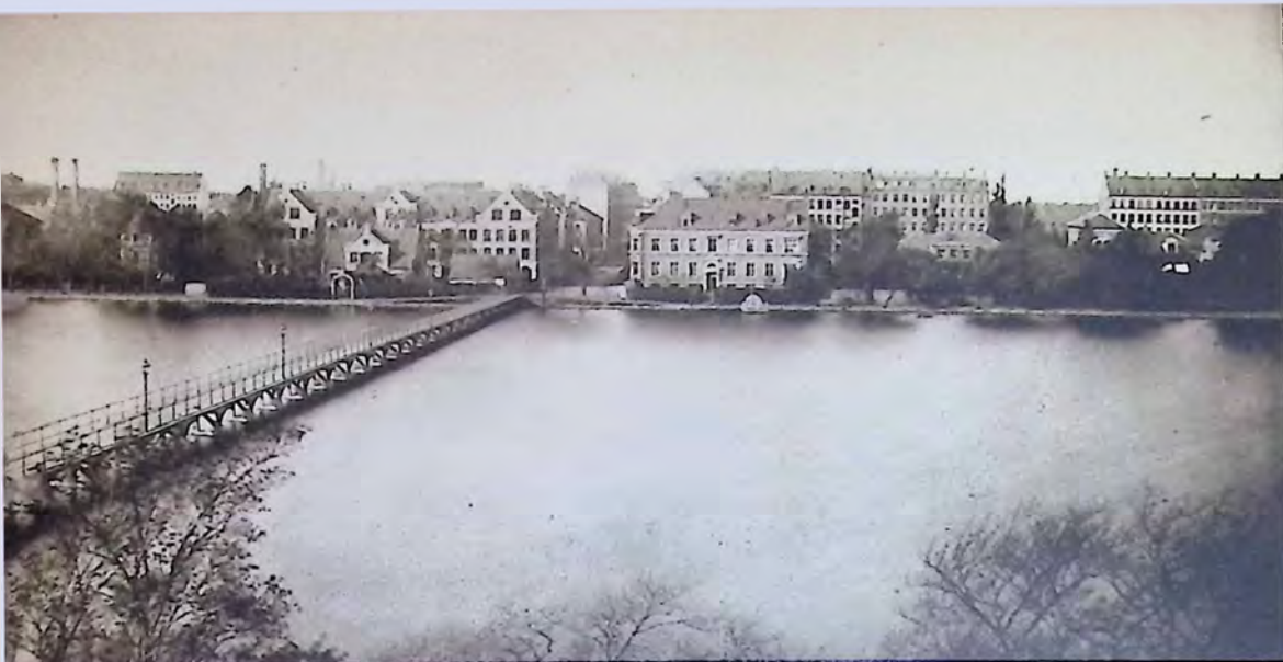
↑ Fredensbro o. 1885 set fra Østersøgade tværs over Sortedamssøen. Broen forbinder Sølvgade med Fredensgade (kendelig i Husrækken) og var anlagt som en Gangbro af Træ.
