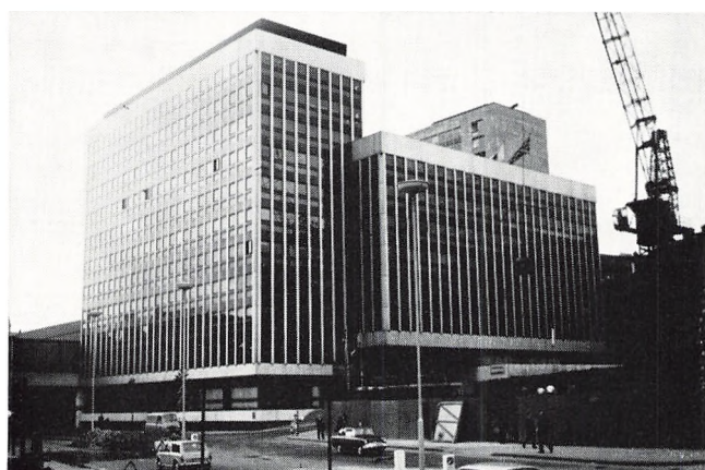
Barclays Bank, Chief Foreign Branch – 10 etager og 850 ansatte. Ejendommen er lejet for 2 år, mens en ny 24-etages bygning opføres på den gamle Chief Foreigns grund.
