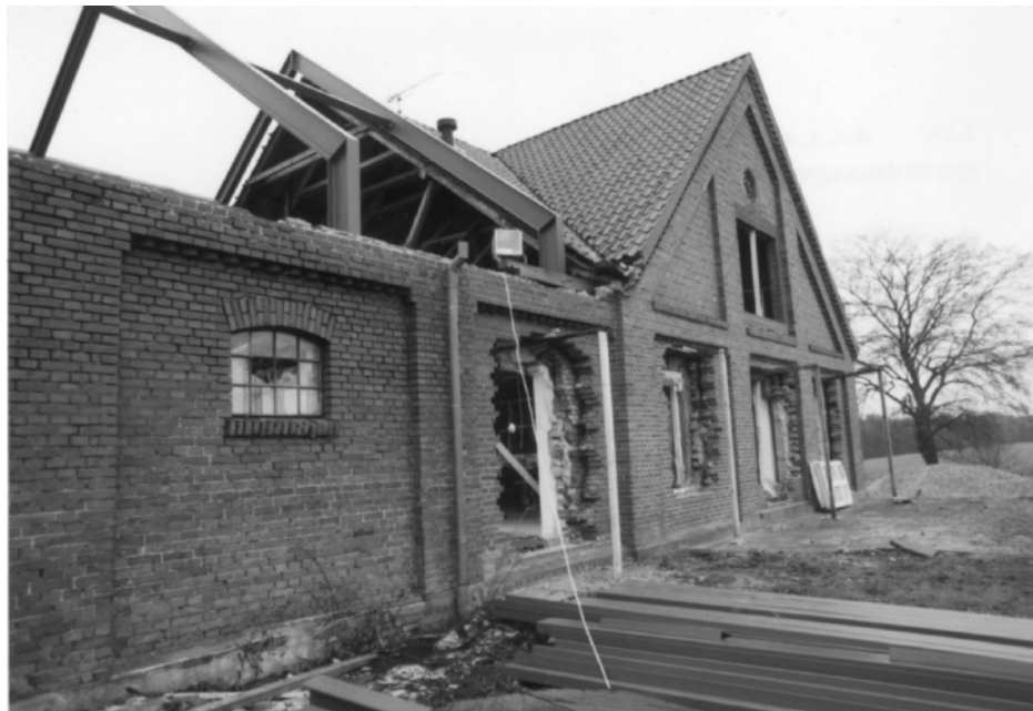
I november 2002 er man i gang med at opsætte stålspær, og de små staldvinduer erstattes af "rigtige" vinduer, stadig i murblændingerne. Murværket blev dygtigt genskabt med røde mursten
