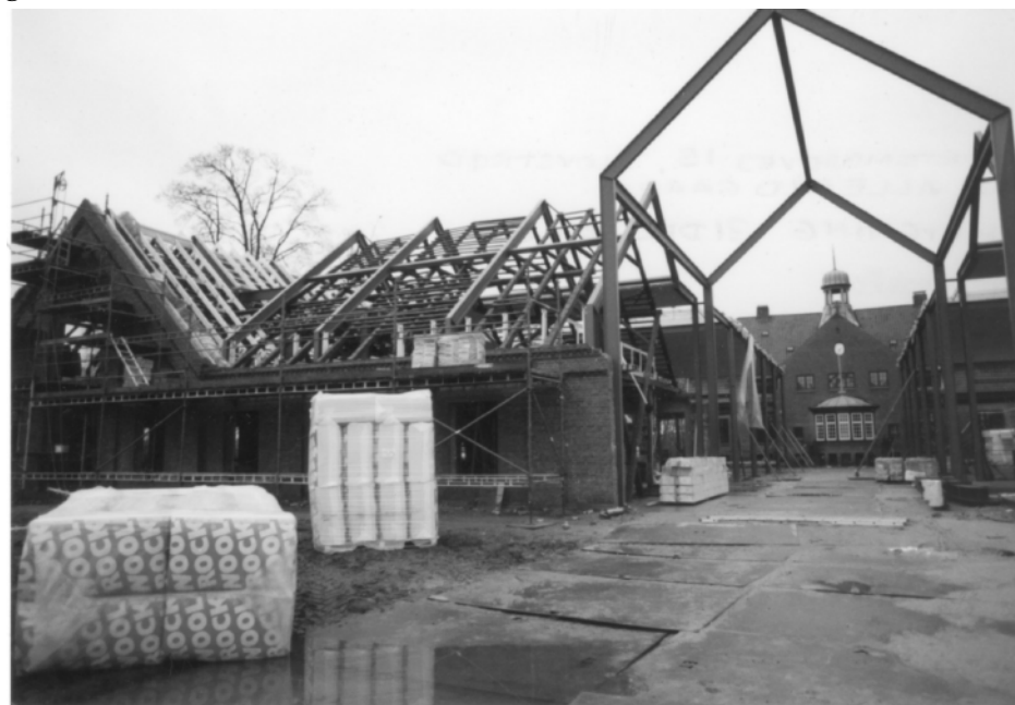
I midteraksen og på højde med hovedbygningen rejses en meget stor frontispice, dec. 2002.
