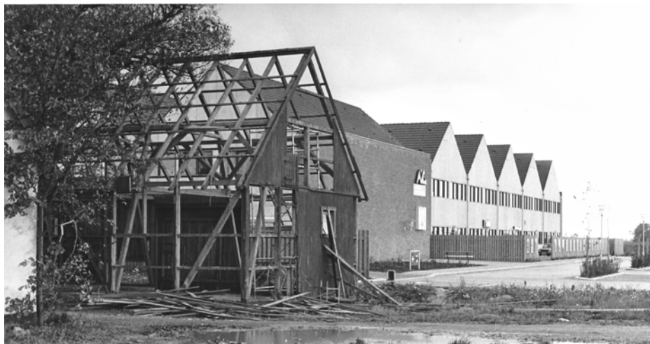
Allerød Vestcenter med p-pladsen ud mod Kollerødvej og Kirsebærgårdens lade, der er ved at blive nedrevet i forgrunden. Man må give kritikerne ret i, at facaden mod Kollerødvej ikke var indbydende. 1980.
