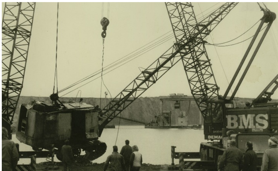
Redning af en kran. I baggrunden ses pontongravemaskinen, der kunne pumpe sand op under vandoverfladen. (1974)
