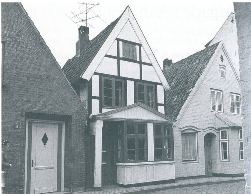
Slotsgade 21 med bindingsværk efter restaurering i 1962. Huset er bygget 1686 som bolig for en af slottets tjenestefolk. Foto: Institut for sønderjysk lokalhistorie.
