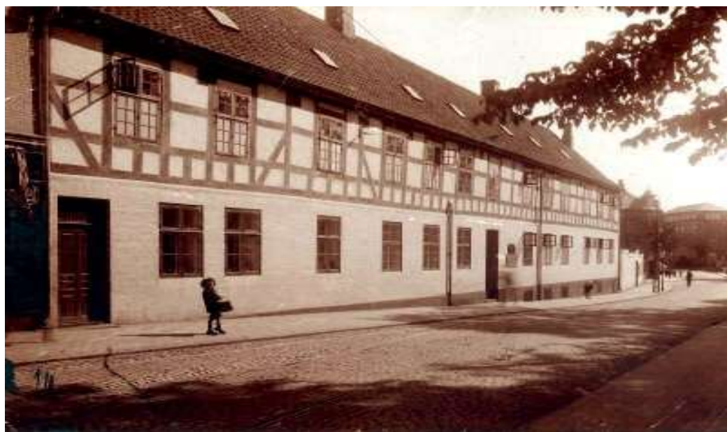
Adresse nu: Klosterbakken 13. Bygningen hører til Odense Tugt- og Manufakturhus, som åbnede for de første indsatte i 1752 og ophørte i 1865. Det blev afløst af Tvangsarbejdsanstalten, der blev i bygningen indtil 1949. Bygningen er fredet. (Odense Bys Museer)
