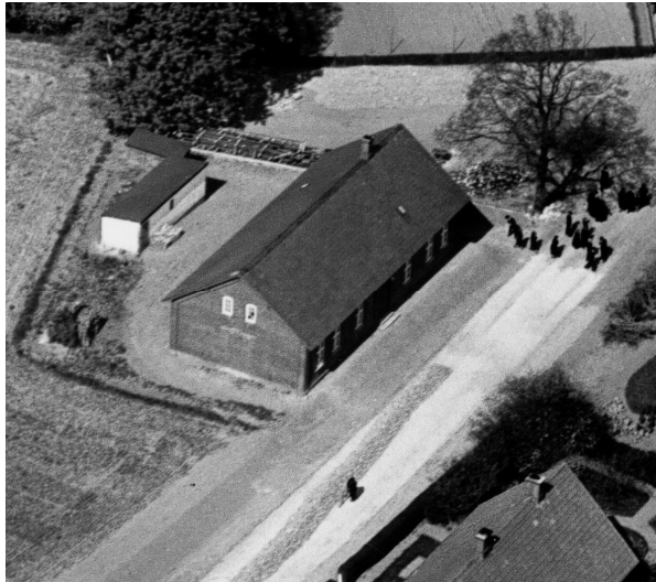
Forsamlingshuset 1939, Huset bagved er toiletter (Das)
