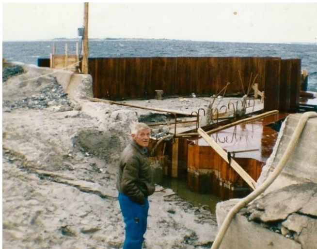
Ove ved havne-byggeriet på Avernakø
