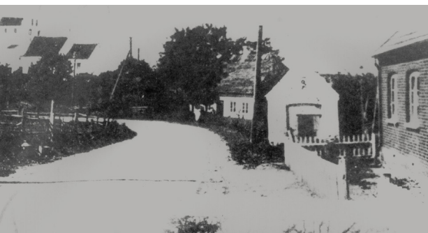
Sprøjtehuset i Ubberud, nedrevet 1958
