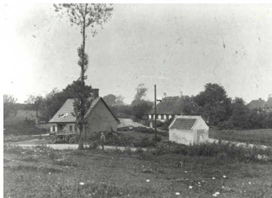
Sprøjtehuset i Korup, nedrevet ca. 1971
