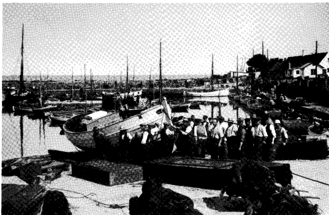
En halvdeksbåd hales på land til bundsmøring i Årsdale. Kølhalingen udførtes som regel om foråret eller tidligt på sommeren. Fiskerne halede båden op ved håndkraft, og en af fiskerne sang for, mens de andre trak i tovet. De store kasser foran fiskerne er hyttefade til opbevaring af levende torsk eller rødspætte. Hyttefadene lå og flød i havnen fyldte med levende fisk, der solgtes til opkøberkvaserne.
