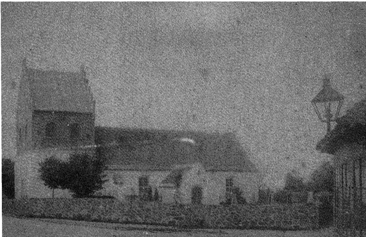
Allinge kirke. Efter opførelsen af det nye tårn i 1865 og før skibets ombygning i 1892.
