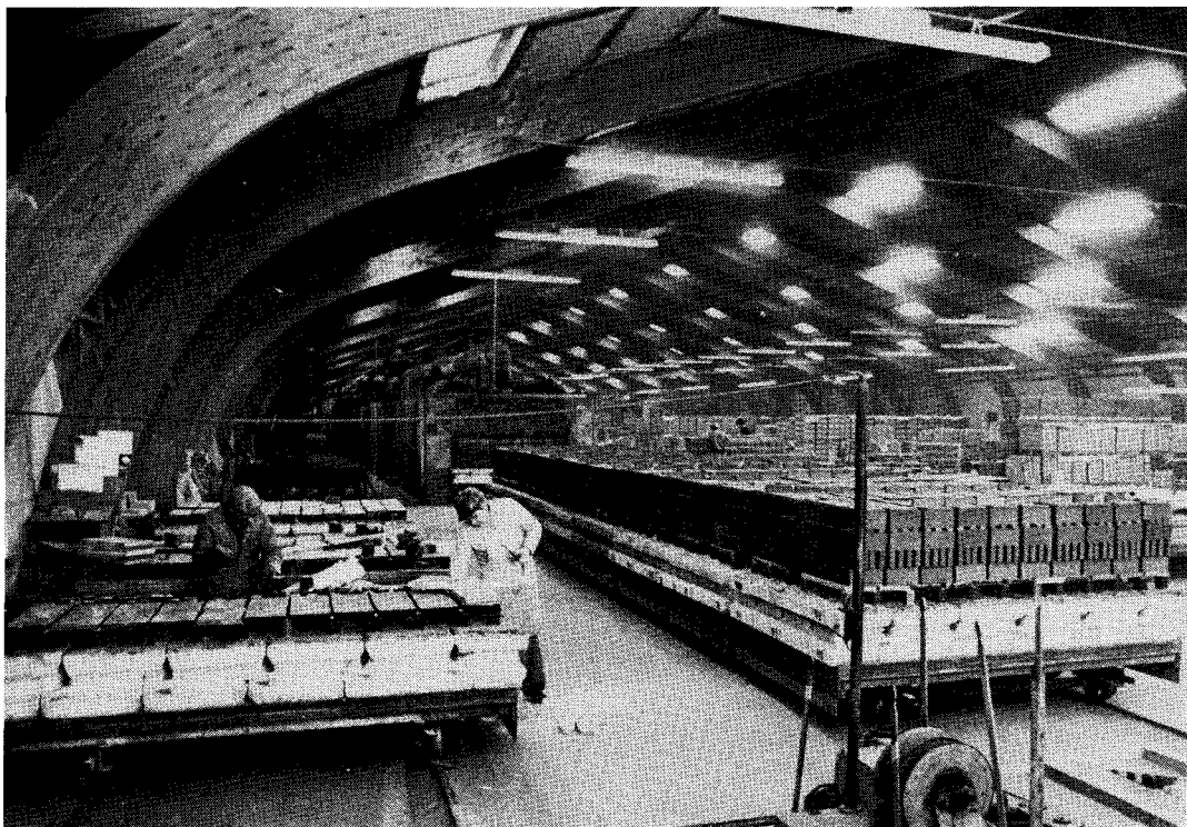
Hasle klinkerfabrik ca. 1970 med tunnelovn III, opført i 1965. Henning Rasmussen t.v. og Benny Petersen t.h. reparerer tunnelovnsvogn. I baggrunden sætter Kim Møller klinker på tunnelovnsvogn. (Foto Algot, Rønne.)
