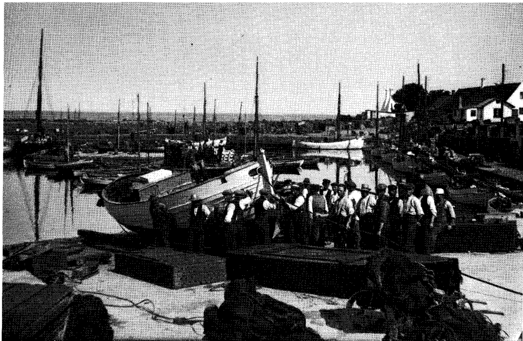
Når de tunge motorbåde skulle på land, måtte alle mand i arbejde med at hale og støtte båden. Sli-skene blev smurt i grøn sæbe, så gled det hele lettere. Årsdale omkring 1920. Foto: H. P. Holm.
