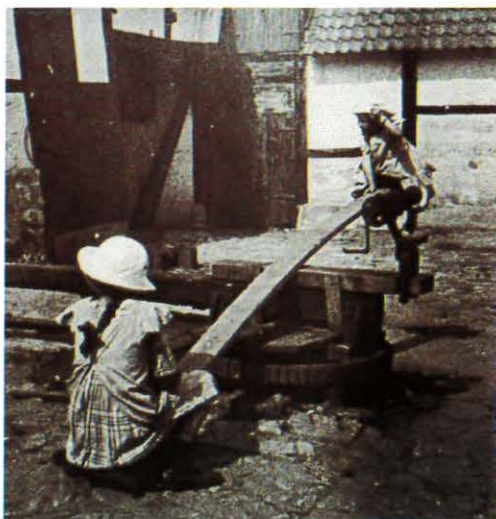
De første kraftmaskiner var en hesteomgang i gården, hvor 2-4 heste gik rundt og rundt og trak et stort tandhjul, der igen trak et mindre tandhjul, der igen trak drivakslen, der gik ind i bygningen. Hestegangen kunne bruges til vippe, og det ses, at en håndslibesten er sat på hestegangens overligger. Med den kunne man slibe sine takkede maskinknive til slåmaskine, aflægger eller selvbinder. Hestegangen trak hakkelsesmaskinen eller en mindre tærskmaskine inde i bygningen. Foto Kjøller, Allinge, Bornholms Museum.
