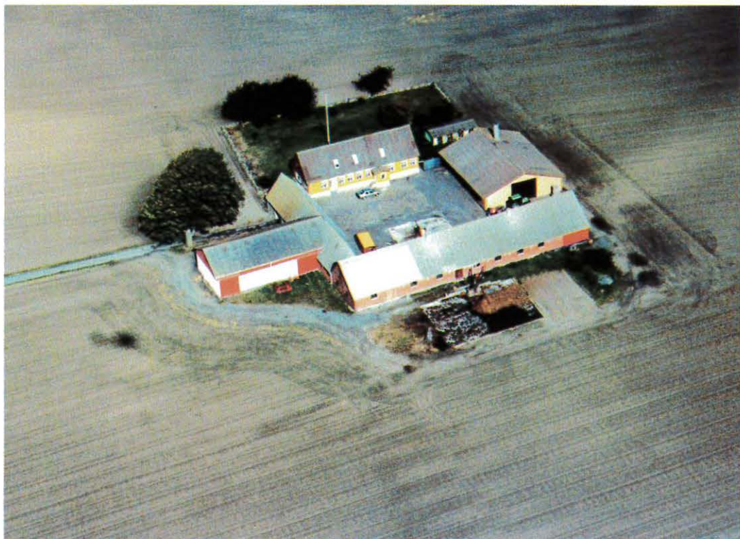
Nyt luftfoto af Aspegård optaget i efteråret 2004, mens markerne endnu var sorte. Kort efter var de grønne af vintersæd rundt om hele gården. I vestlængen var der i 90'erne indrettet plansiloer med lufttørring i gulvet. Læden mod vest er bygget i 1928, da der var brug for mere ladeplads til kornet. I østlængen er halmfyr og maskinlænge og i syd svinestald. Foto Klippefly.
