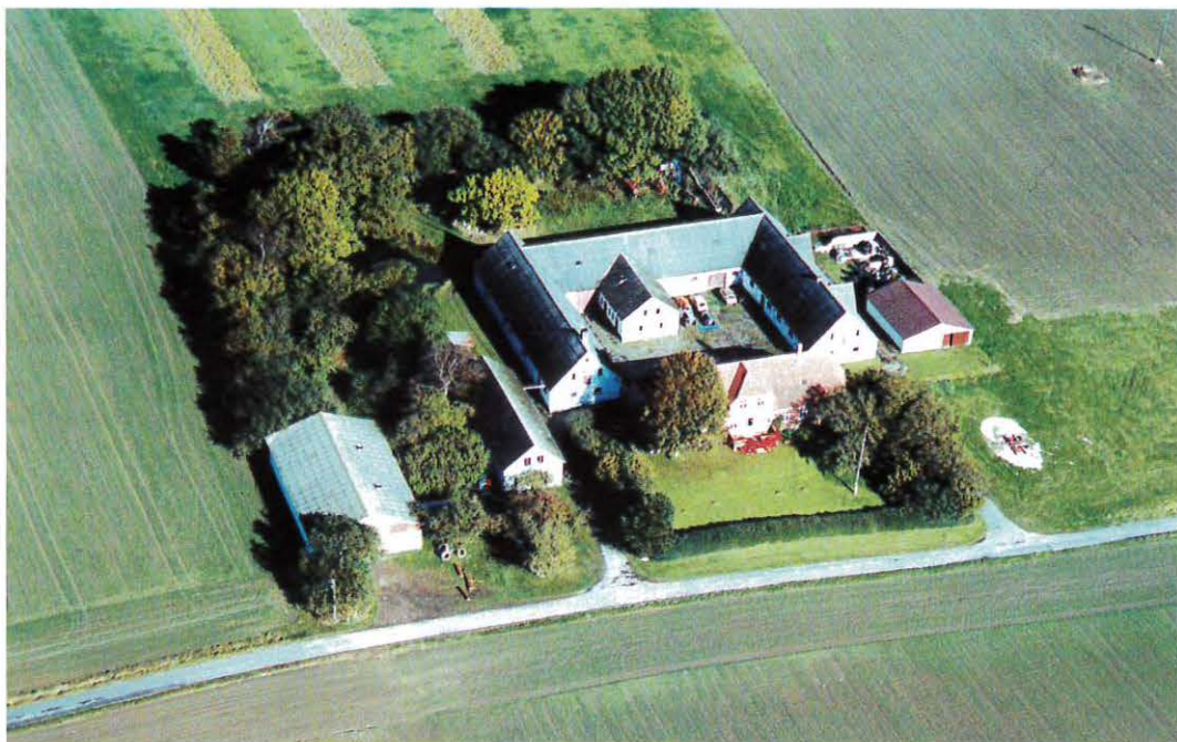
Luftfoto af Kaasegård i dag. Man ser tydeligt de forskellige længer og møddingspladsen mod øst oven for det gamle maskinhus af træ og yderst mod vest maskinlængen fra 1984. Foto Klippefly 2004.
