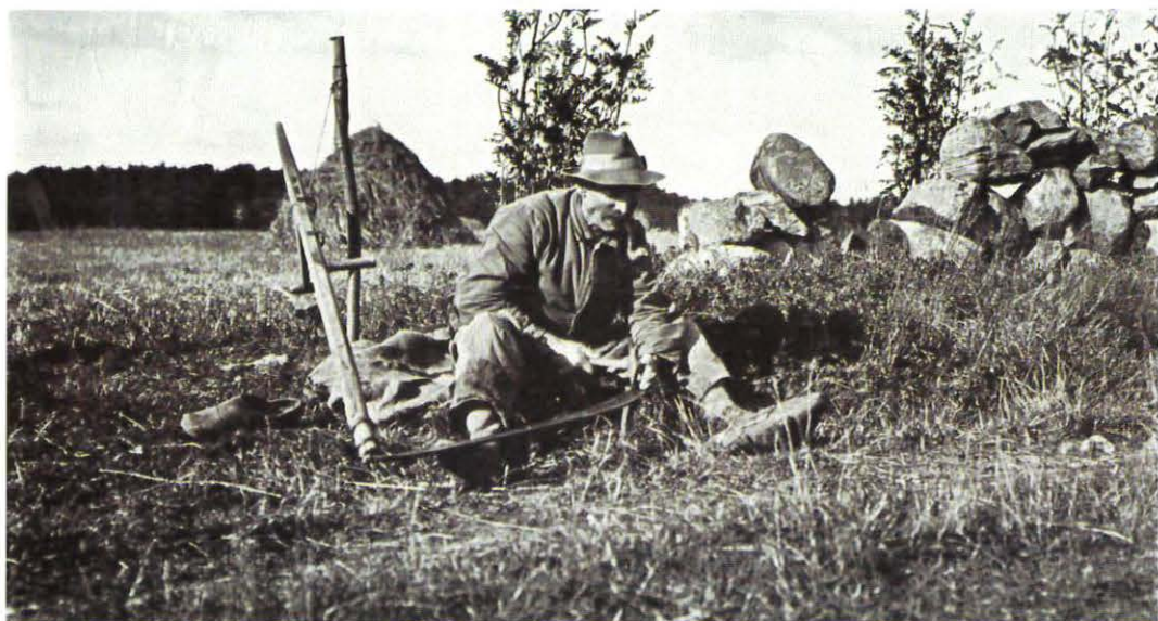
Høst i 1800-tallet foregik med le/«sejs», som det ses her; hvor Hans Ipsen, Thomasløkke ved Hammershus, harer sin »sejs«, skærper den ved at banke med pennen af en hammer på den yderste ½ cm af bladet. Det er lagt på en lille ambolt stukket ned i jorden. Han har taget træskoene af for at kunne styre bladet med foden. Leskaftet, »bommen« er ophængt i en »haresule« og bundet med en snor med en sten i. Foto Kjøller, Allinge, vel før 1900. Bornholms Museum.
