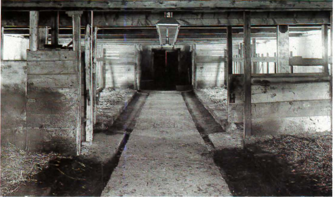
Den nye kostald fra 1899 set indvendig efter den er taget i brug. De omtalte »Klaffær« som dyrene stod fæstnet i, er de lodrette stænger, den ses mellem fodergangene og båsene til hver side i stalden. I midten ses den »fine« petroleumslampe. Dette foto brugte dyrlæge Albrechtsen fra Aakirkeby i en artikel i Dansk Kvægavl 1902-03. Foto Thomas Hansen, Bornholms Museum.
