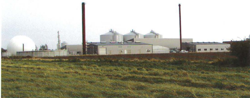
Biokrafts biogasanlæg ved Tvillinggård i Aker. Foto Henrik Vensild.
