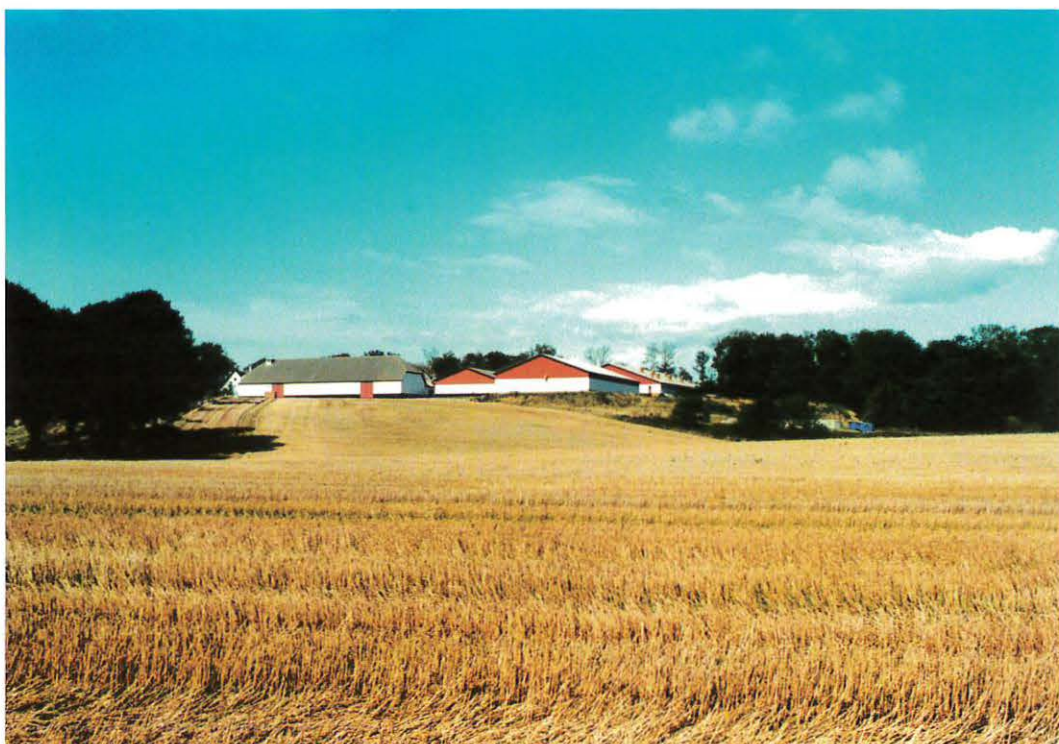
Bygningerne på Ladegård, som de ses fra landevejen. Til højre ses en ny maskin- og kornlænge og bagved ligger den nye svinestald. Foto Henrik Vensild 2004.
