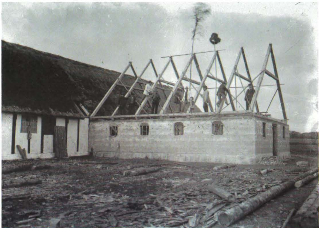
Rejsegilde på den nye kostald i 1899. Midt i billedet ses gårdejer Adolph Sonne i lys jakke med sønnen Knud ved hånden. Ellers er personerne håndværkere og arbejdsmænd samt måske en af bygmestrene? Man ser hvordan østlængen er opført kun med lodrette bindingsværksstolper i væggene, med gennemstukne hjælker for oven og så formentlig er der en indre rem på tværs af stolperne, et såkaldt sidebånd, der holdt stolperne i passende afstand fra hinanden. Foto Thomas Hansen, stedson på Risegård, Bornholms Museum.
