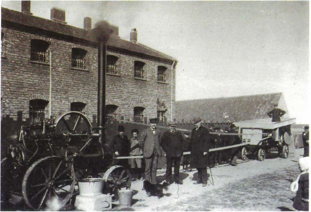
Maskinhandler H.J. Jensen, Aakirkeby demonstrerer et damptærskéværk, dvs. et lokomobil der trækker et tærskéværk, foran Arresten i Rønne, engang o.1900. Man ser tydeligt den lille flunkende nye dampmaskine på hjul, med den lange drivrem hen til tærskéværket, hvor kornet lægges i foroven. Foto Bornholms Museum.
