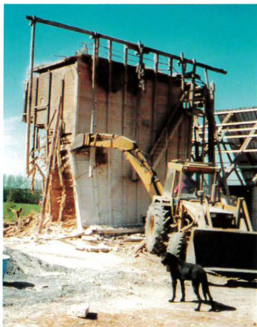
H.A. Sonnes gamle og særdeles brugbare siloer fra 1955'erne måtte falde i 1999, efter at bygningen var blevet slemt beskadiget af stormen. Foto i Privateje.
