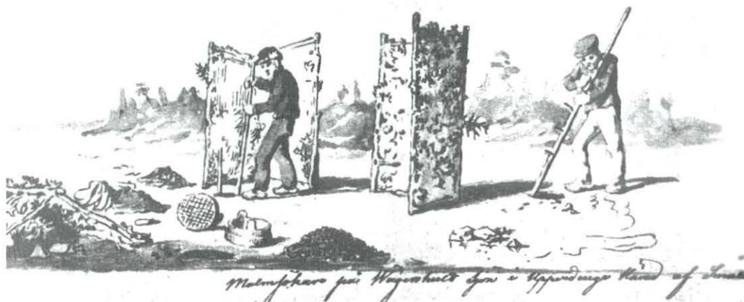
Der findes en ganske enestående tegning af, hvordan jernet er blevet hentet op fra søernes bund. Man ser optagning af sømalm fra isen ved hjælp af nogle ganske enkle redskaber og med ligeså simple skærme, der giver læ mod vinden. Lavering af Kilian Zoll 1852. (Fra Från blästbruk till bruksdöd).
