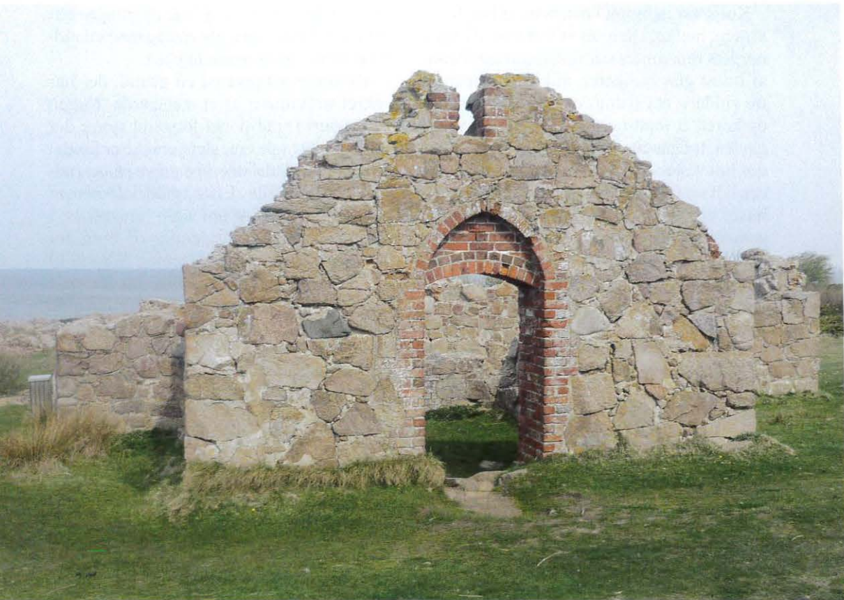
Indgangen til kapellets våbenhus set fra syd. Det bemærkes, at døråbningen er spidsbuet på ydersiden og bredbuet på indersiden. Mens døren, utvivlsomt ligesom de længst forsvundne vinduer, er muret op i brændte teglsten («munkesten»), så er murene i øvrigt opført i groft tilhugne kampesten, hvorimellem sprækker er fyldt ud med brokker af teglsten. Foto af Sascha Helsengren Hansen 2009.
