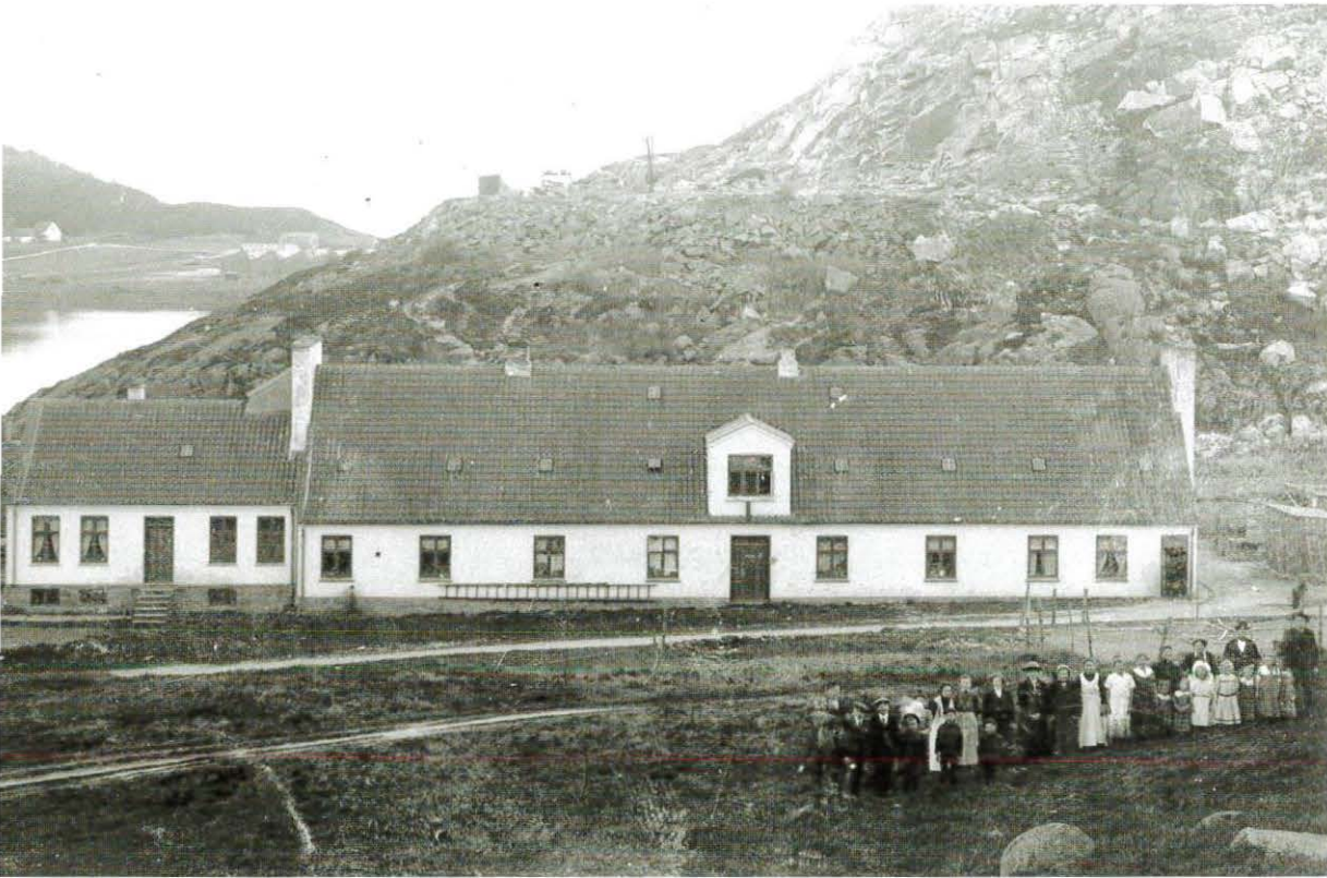
Fig. 29. Humledal beliggende ved vejen op til Hammerfyret, i baggrunden ses Hammersøen. Huset er den tredje af de boligbebyggelser, Hammerværket o. 1890 lod opføre til sine arbejdere. Humledal rummede fem boliger. Gustav Gummesen [GG] fortalte, at huset endnu ikke var helt færdigt, da hans familie flyttede ind i det i 1891 ved ankomsten til Bornholm. Ukendt fotograf, o. 1891-1900. BM 72x11.
