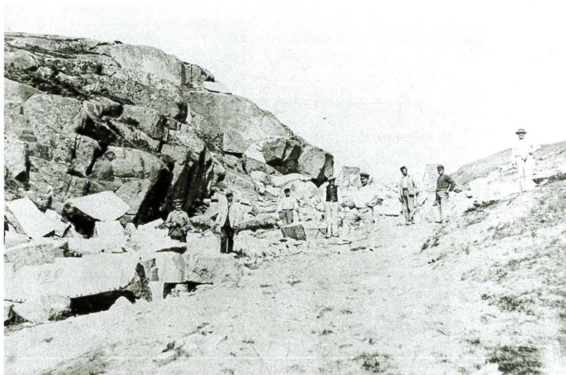
Fig. 20 Hammerværket (?). I stenen forrest til venstre i billedet ses i randen tydelige spor af kilehuller fra kløvning af blokken. Ukendt fotograf, uden år. BM 64x6.
