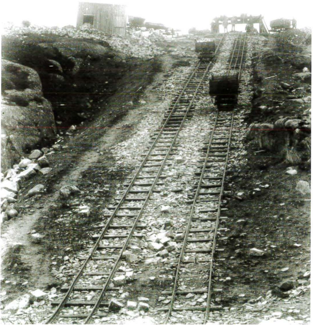
Fig. 13. Dobbeltsporet tipvognsbane på Hammerværket. Banen bestod af to tipvogne forbundet med en kæde, så den nedadkørende, fulde vogn trak den tomme vogn op. Kæden var muligvis den, der var blevet indkøbt til det nystartede Hammerværk i 1890, men som da ikke kunne bruges pga. manglende maskinkraft. Foto Bendt Kjoller; o. 1900. BM.
