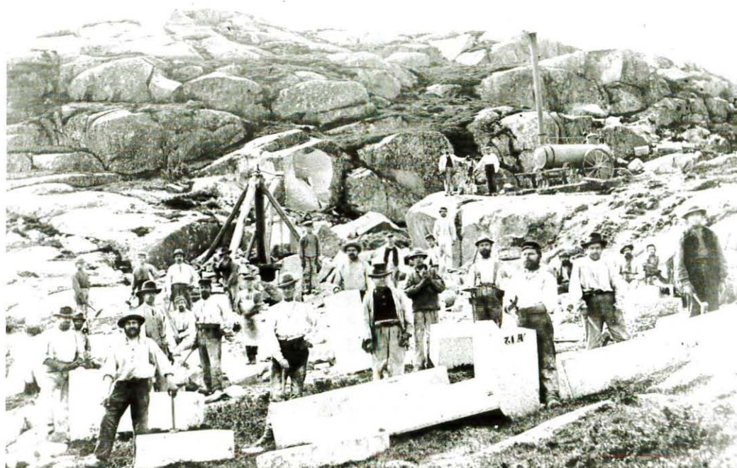
Fig. 9. Tidligt foto af stenbrydning på Hammeren. Manden helt i hvidt neden for den transportable dampmaskine (lokomobile) er A.R. Wiberg, der anlagde et brud på Hammeren i midten af 1880'erne og siden, i 1891, solgte det til Hammerværket. Midt i billedet ses en kran til løft af klippeblokke. Ukendt fotograf, o. 1890. BM 64x6.
