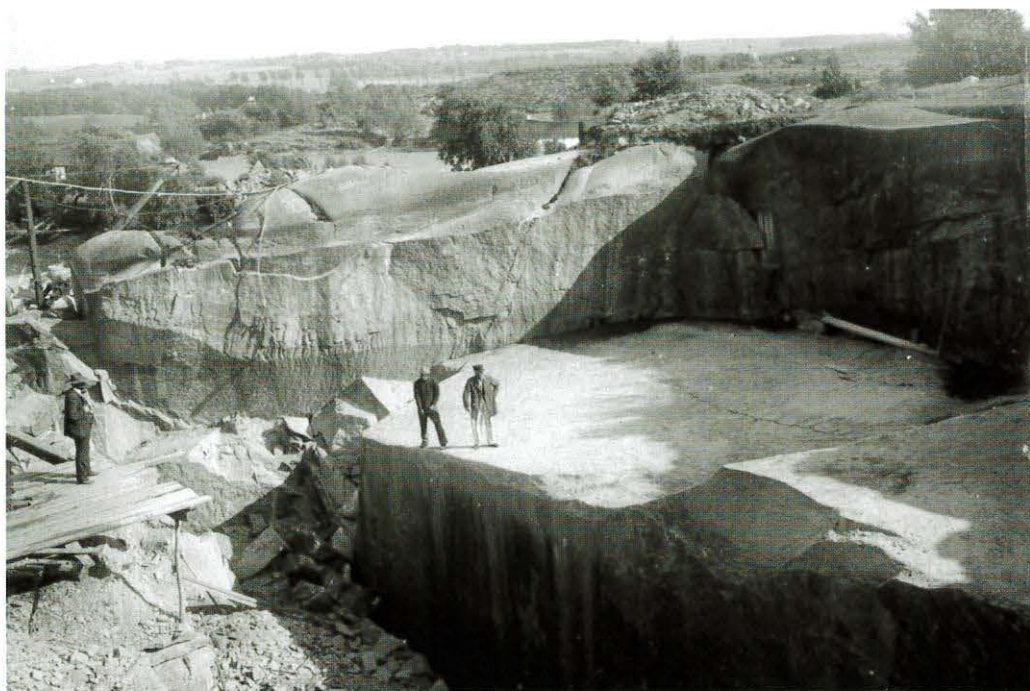
Fig. 6. Det såkaldte Krystalso-brud på toppen af Hammerknuden med udsigt ud over det omgivende landskab. Billedet viser tydeligt, hvordan man oppefra arbejdede sig ned i granitten. Foto Bendt Kjøller, o. 1890-1900. BM.
