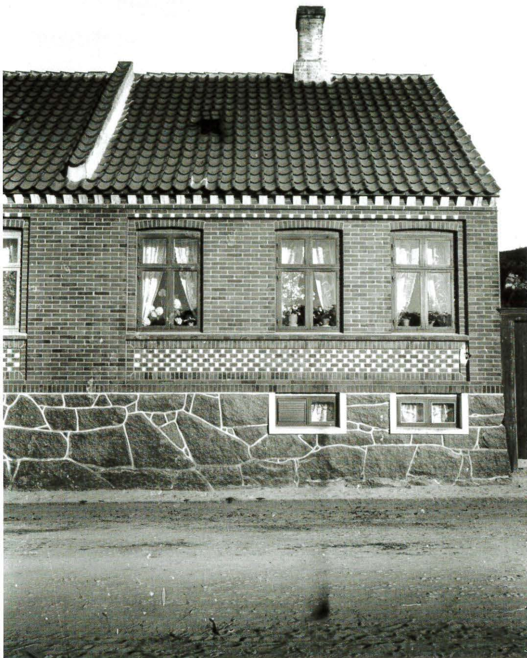
Fig. 25. Hammershusvej 51 (tidligere Storegade), Sandvig, i 1970 ejet af Gustav Gummesen [GG]. Huset var i 1896 blevet opført af hans far, Carl Gummesen, indtil da havde familien efter flytningen til Bornholm boet i Humledal. På husets granitsokkel fornemmer man tydeligt, at faderen var stenhugger og stolt af sit håndværk. Ukendt fotograf, o. 1900. BM 1466.
