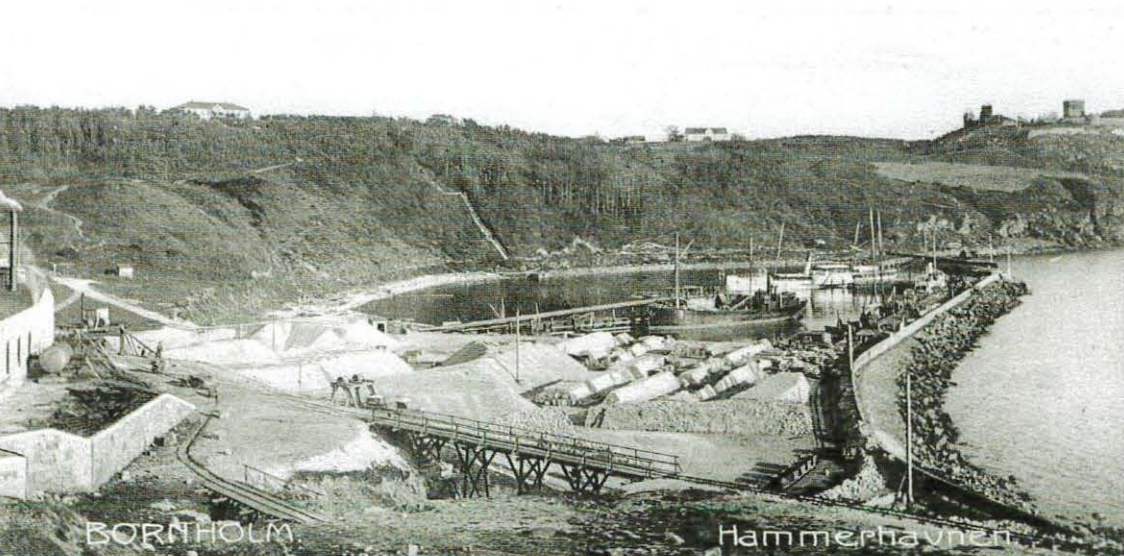
Fig. 11. Sænehavnen eller Hammerhavnen anlagdes 1891-92 til udskibning af sten fra Hammerværket. Bemærk bunkerne af brosten, der ligger og venter på at blive lastet. På området mellem Hammersøen og havnen opførtes bl.a. et stort maskinhus og en dobbeltbolig til formanden og maskinmesteren. Oven for havnen ses fra venstre Blanchs Hotel, Hotel Hammershus og Hammershus Ruiner. Postkort, o. 1904. BM.
