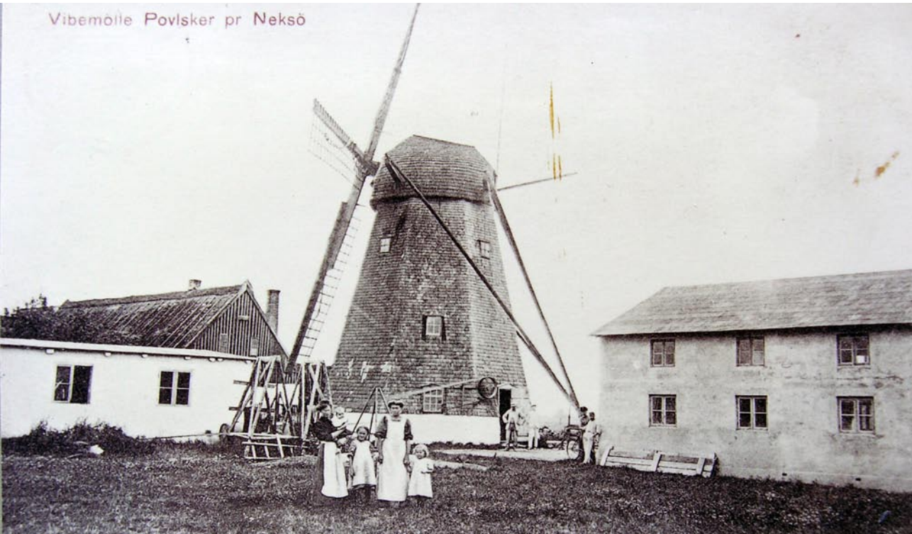
Den hollandske Vibemølle blev bygget i 1864 og købt for penge tjent ved guldgraveri af Peter Lou omkring 1880, da han vendte hjem fra New Zealand. Af optegnelsesbogen fremgår det, at han fik repareret vingerne og beklædt møllen med spån, som det ses her. Han afhændede allerede møllen igen i 1883, hvor han flyttede til en ejendom på Nørremark. Postkortet af møllen fra ca. 1910 viser de senere ejere, møller H.P. Hjorth med familie 6 . Foto Bornholms Museum.
