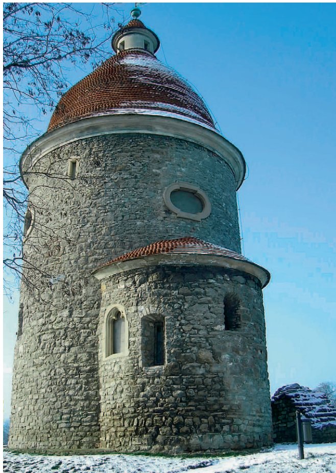
Rundkirken Skt. Georg i Skalica, Slovakiet blev oprindelig opført ved en borg i første del af det 11. århundrede. I 1949 blev den rekonstrueret pga. skader efter krigen. Foto Wikipedia, 2006.
