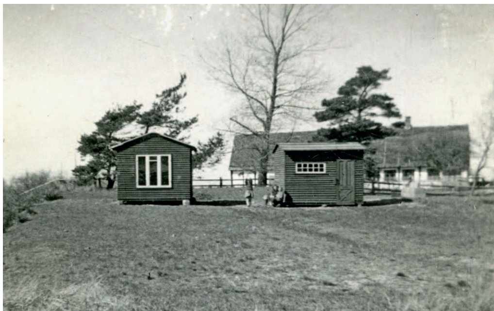
Aage Pedersen udstykkede sommerhusgrunde i 1947. Der var forbud mod at bygge sommerhuse pga. materiale-mangel. Derfor indkøbte man to små færdige huse i Rønne og flyttede dem til grunden.
