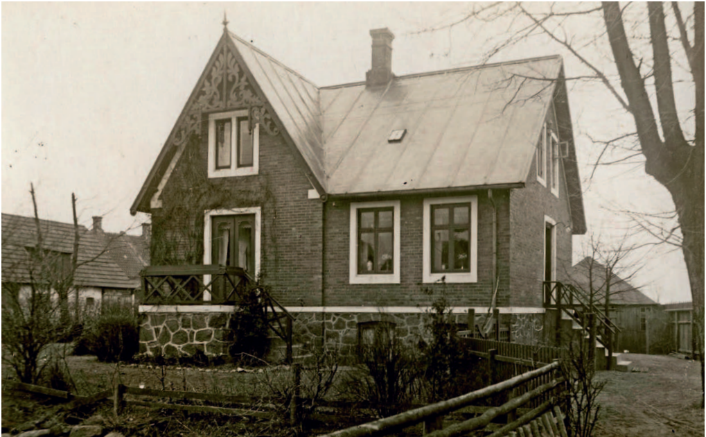
Per Andersens privatbolig, i dag Vesterbro 5. Forrest anes enstensætning, her var en dam med vand, der blev brugt til dampkedlen i en nærliggende bygning. Fotopostkort o. 1920. Ukendt fotograf.
