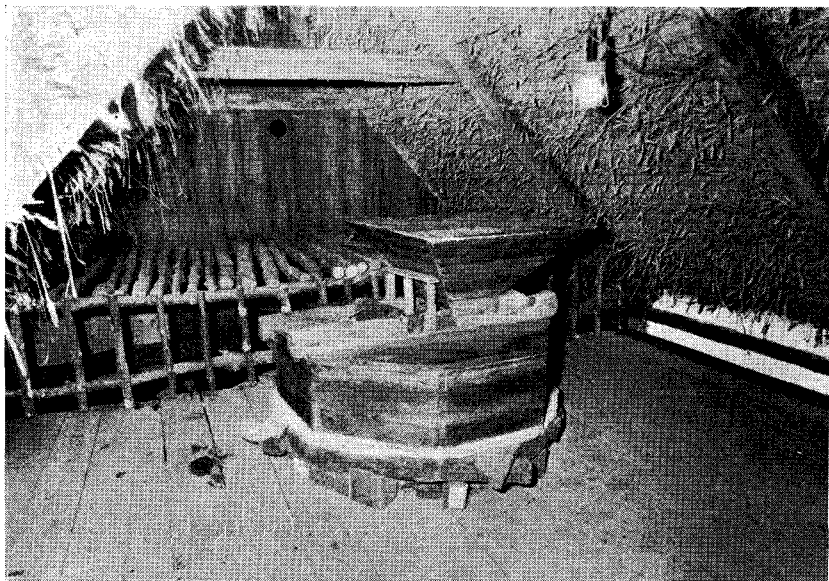
Fig. 3, neg. nr. 1167.14. Kværnloftet. Besætningen stammer fra DK-415-Lille Munksgaards Mølle, stenene fra DK-411-Vasagaardens Mølle. Slusegaardens Mølles inventar var næsten helt ødelagt. Bag tremmerne i baggrunden gaar vandhjulet.
