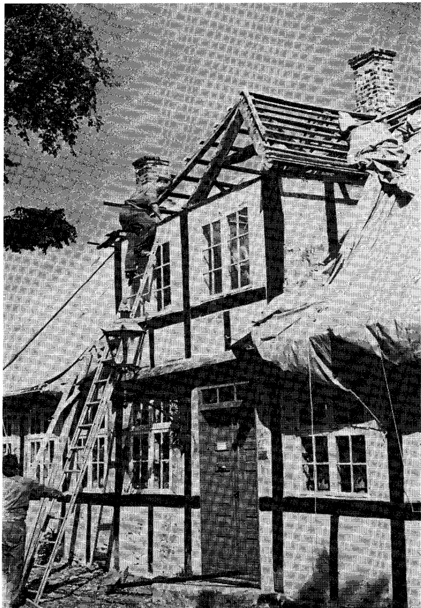
Fig. 5. I 1976 var Erichsens Gaard lukket på grund af omfattende restaurering. Den største opgave var forbedringen af tagkonstruktionen og nylægning af hele taget på forbuset. (J. Appel foto).
