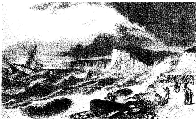
Redningsaktion med raketapparat på en klippekyst. 1. raketten afskydes, 2. der arbejdes med redningsstolen. Fra en engelsk reklamebrochure ca. 1860. (Marinemin. 784-09-2. Redningsvæs. Jr. sager. R.A.)
