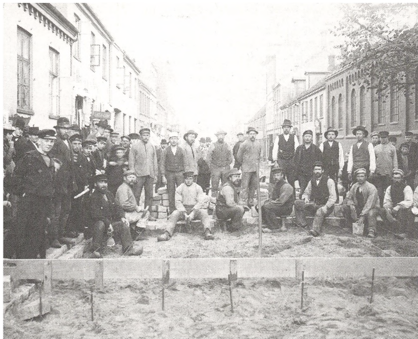
Søndergade bliver brolagt i 1895. Arbejderne er standset et øjeblik, mens billedet bliver taget. Fotografen har stået ude i Sønder Allé, til højre ligger Frichs fabrik. Nu ligger her Hafniahus, som tidligere kaldtes Reginabygningen.
