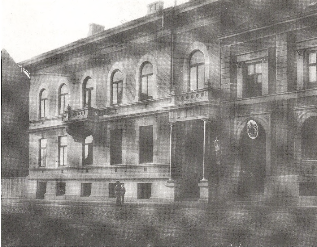
Korn- og Foderstof Kompagniets administrationsbygning i Havnegade 8, fotografi fra 1901. Arkitekten var Rudolf Frimodt Clausen, der også 1896-1910 tegnede fabrik for Otto Mønsted.
