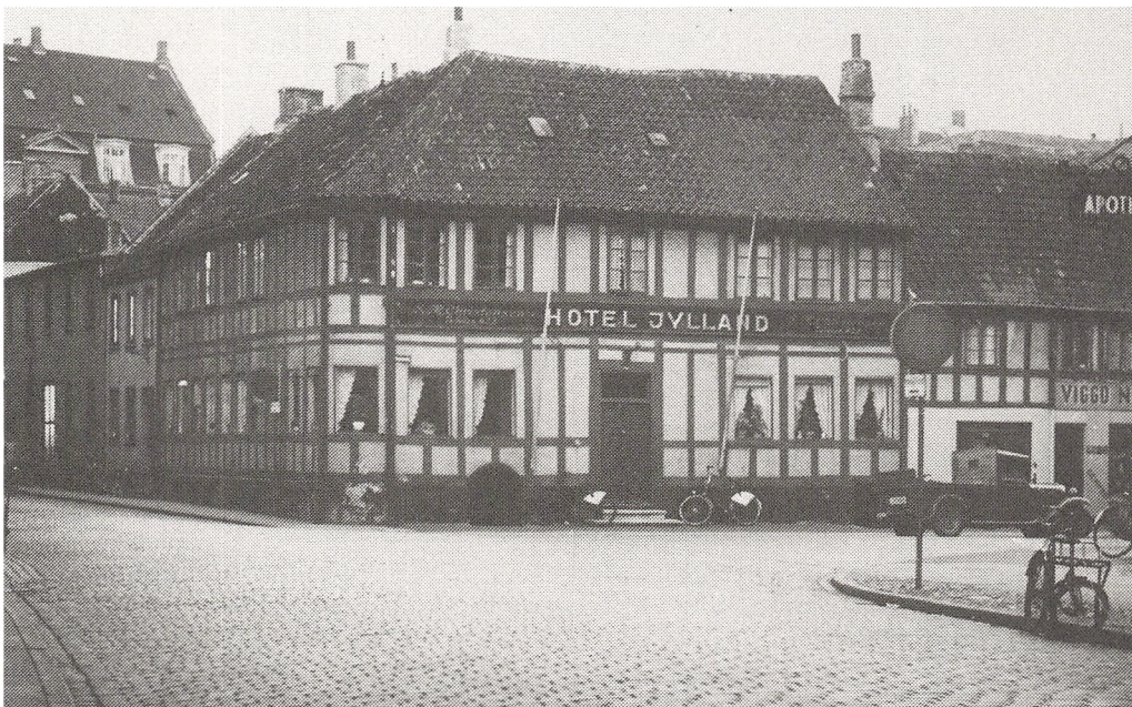
Nørreports udvidelse kostede husrækken i gadens sydlige side livet. Det gik bl.a. ud over Hotel Jylland, der var opført i slutningen af 1700-tallet. Billedet er taget fra Nørreport ned mod Kystvejen. Gaden ind til højre er Studsgade. (1954)
