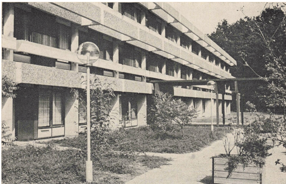
Kollektivbebyggelsen »Sandmarksbo« mellem Skovbo og Ringvejen i Køge har såvel en plejeafdeling som en boligafdeling, og der er både almindelig udlejning af lejligheder og salg af ejerlejligheder. Byggeriet er opført af »Foreningen til fremskaffelse af boliger for ældre og enlige«. I bebyggelsen findes der fælles faciliteter såsom restaurant, opholdsstue, selskabslokaler, gæsteværelse m. m.
