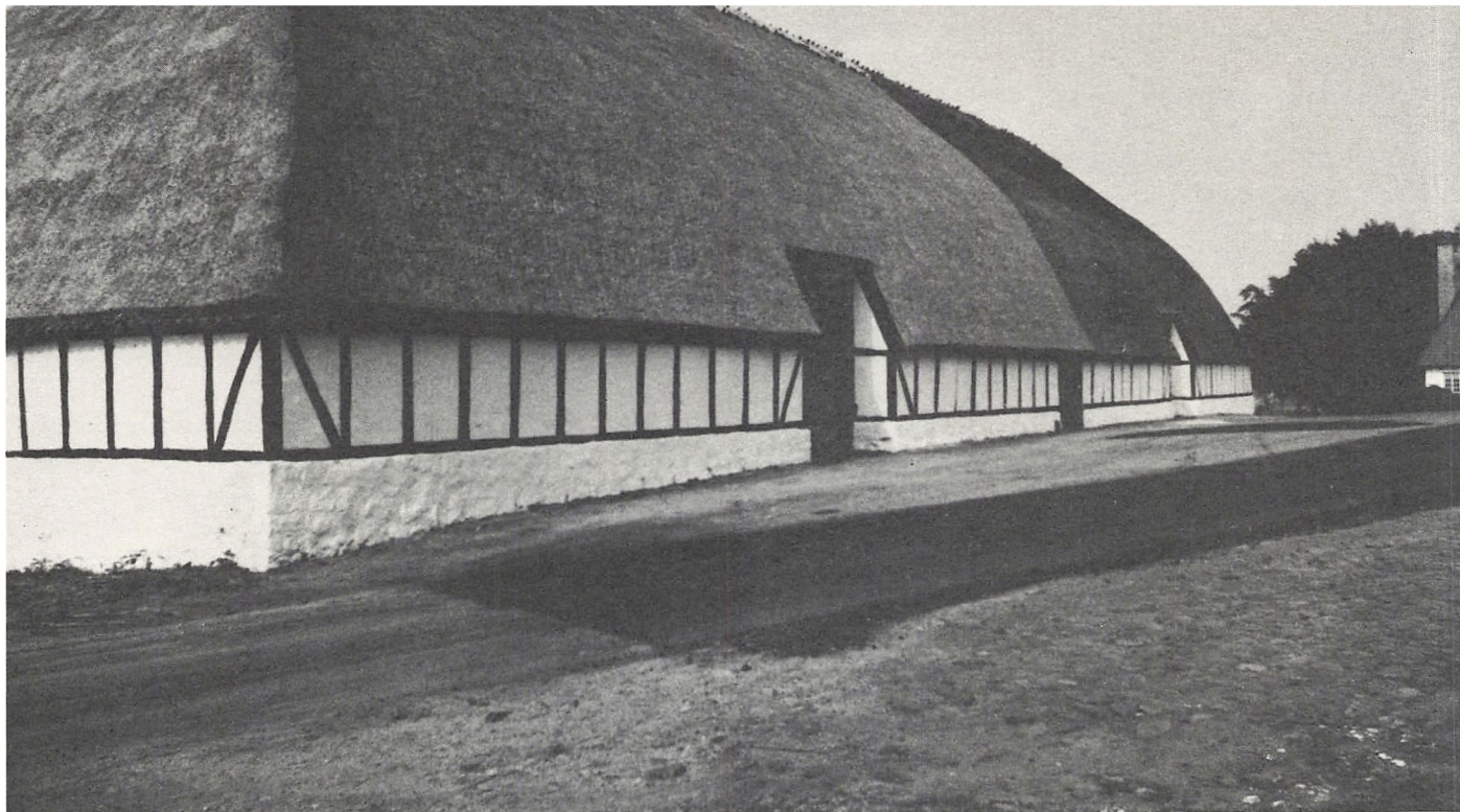
Hovedbygningen på Falkenstein, tidl. Pebringegård, er opført umiddelbart efter 1774 af den daværende ejer finansråd Georg Ditlev Frederik Koës. Materialerne til den og avlsgården er i følge overleveringen hentet fra det nedbrudte Antvorskov kloster. Nationalmuseet har medvirket ved bueladens restaurering og har vist sig interesseret i evt. at flytte den til Frilandsmuseet.
