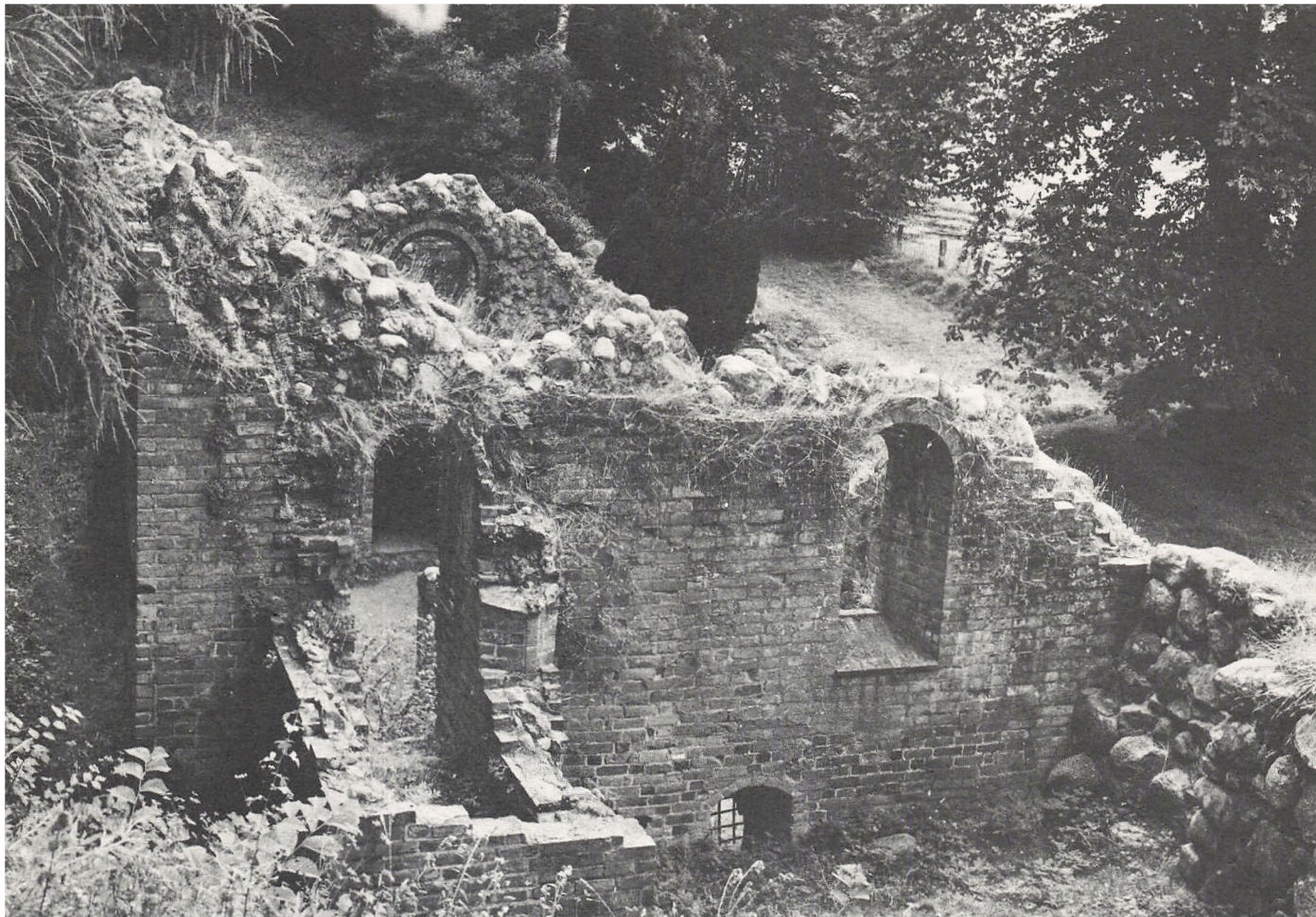
På en skråning synlig fra motorvejen ligger de udgravede ruiner af Antvorskov Kloster. Ruinerne er de betydeligste på Sjælland og stammer fra klostrets ældste tid omkr. 1200. Nationalmuseet startede udgravningerne i 1887 og har derefter i flere omgange foretaget undersøgelser på stedet.
