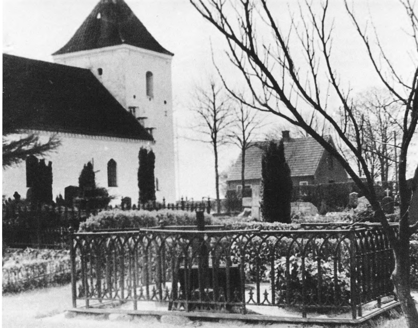
Foto: M. Skabelund
